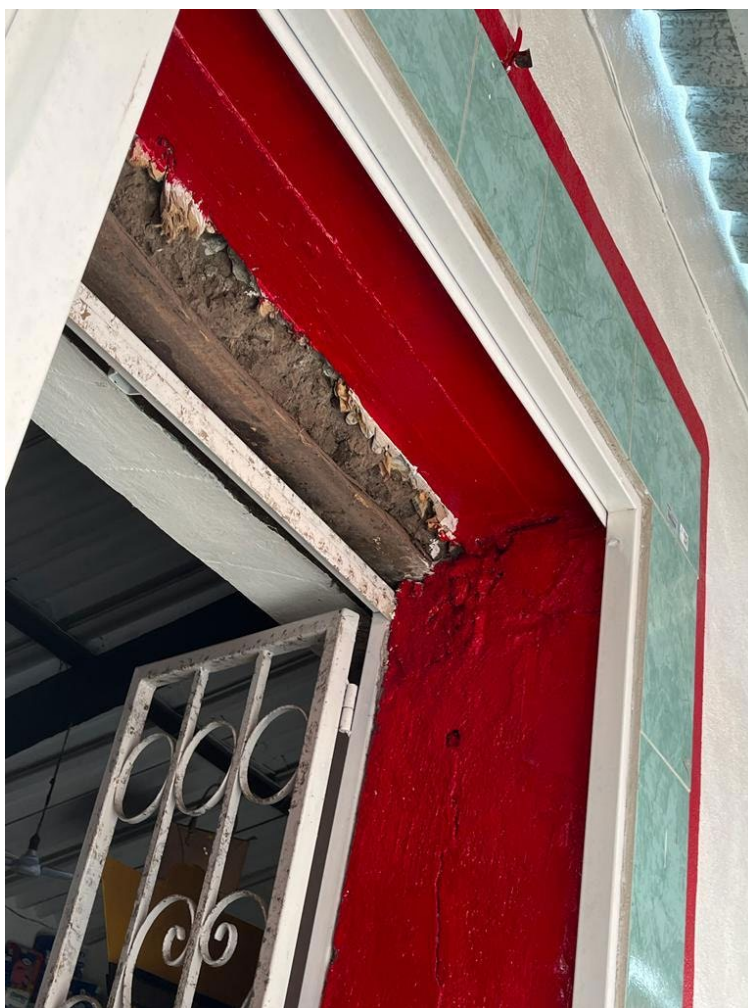
Figura 5 Intervención en casa de adobe con materiales contemporáneos Fuente: Fotografía de la autora (2023)
