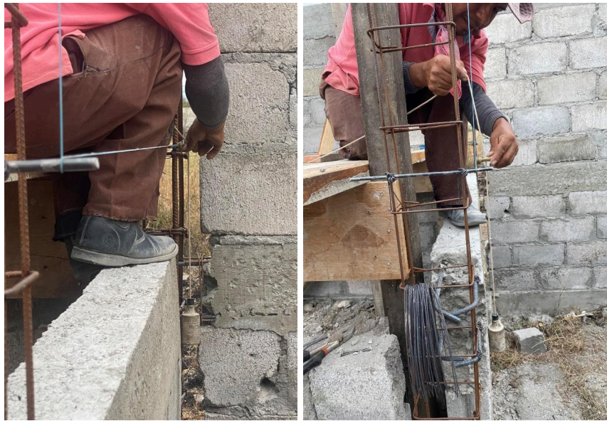
Foto 4 y 5: Nelson saca el plomo para poner sus hilos y continuar pegando piezas de tabicón. Xochitepec, Mor., Cristian Salas Juárez, 2023.
