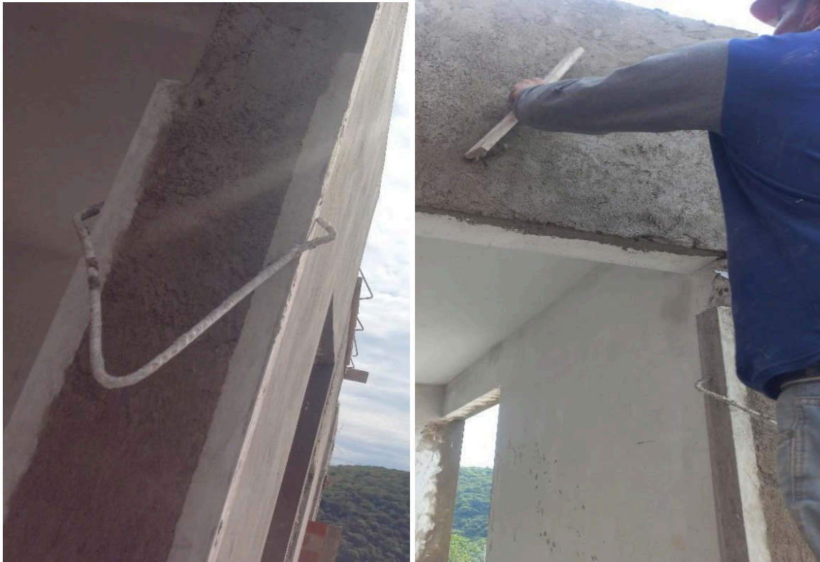
Foto 29 y 30: El mai Memo aplanando y emboquillando casas/habitacionales HABIZA. Xochitepec, Mor., Cristian Salas Juárez, 2023
