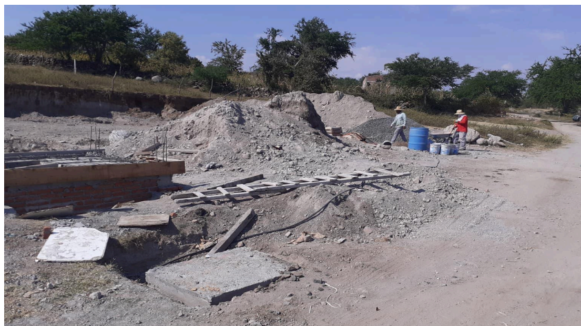
Foto 32: Una cisterna de agua con su registro de agua potable. Xochitepec. Mor., Cristian Salas Juárez, 2021.
