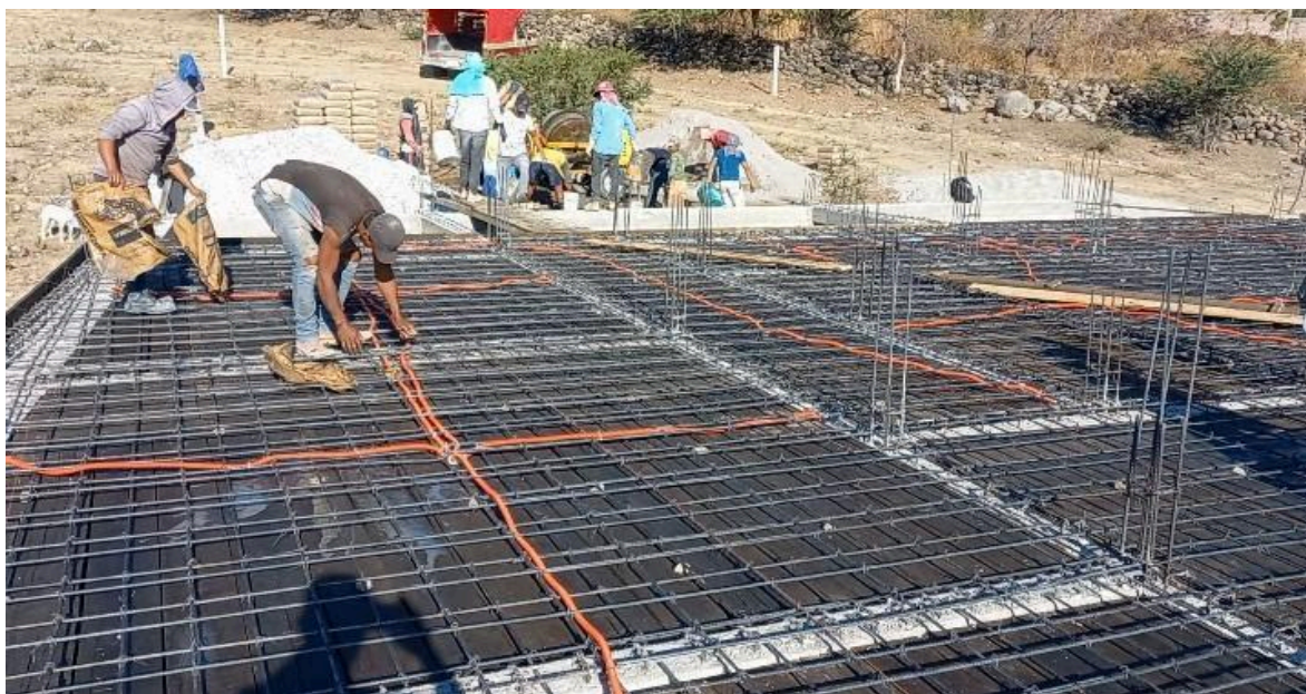
Foto 26: Otros chalanes pondrán piedras pequeñas (calzar) entre las varillas y las tablas para que la revoltura entre por todas partes y no quede porosa. Xochitepec, Mor., Cristian Salas Juárez, 2022.
