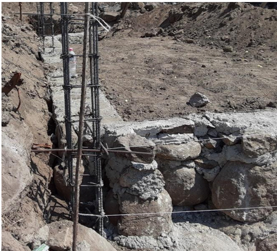
Fotos 2 y 3: Los hilos marcan los límites (línderos) de la obra o el tramo que se construirá. Xochitepec, Mor., Cristian Salas Juárez, 2022.
