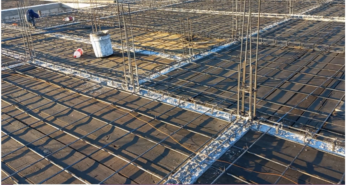
Foto 24: Primera tendida de varillas de una losa de una casa/habitacional. Xochitepec, Mor., Cristian Salas Juárez, 2022.
