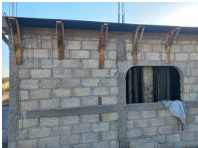
Foto 25: En un colado de losa se debe considerar el desnivel del desagüe del techo. Xochitepec, Mor., Cristian Salas Juárez, 2022.
