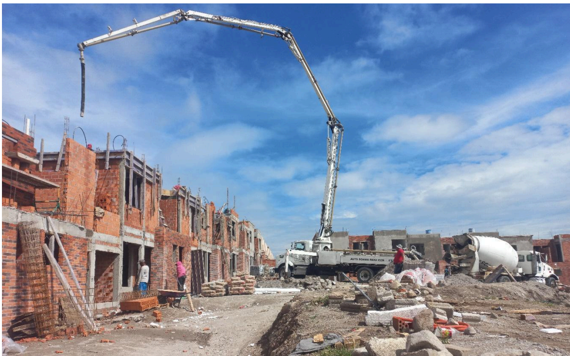
Foto 44: Construcción del condominio “13” por la empresa HABIZA. Xochitepec, Mor., Cristian Salas Juárez, 2022.
