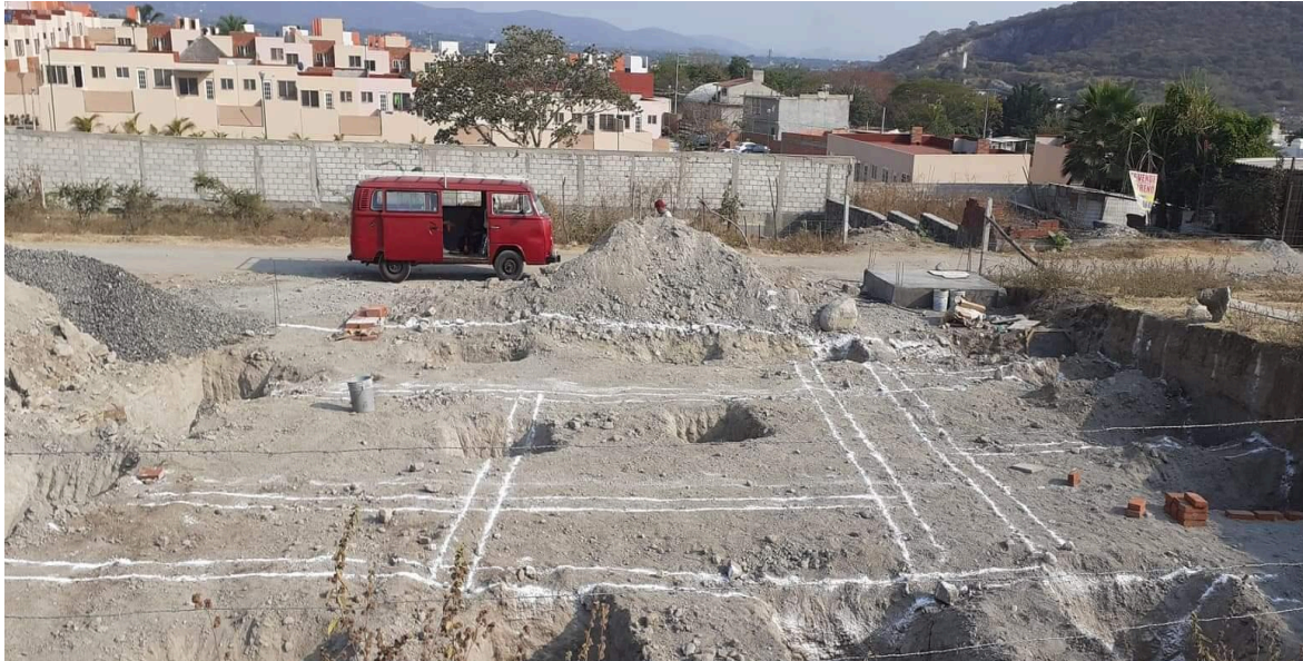
Foto 12: Trazos con cal para marcar y escarbar las cepas de una casa/habitacional. Xochitepec, Mor., Cristian Salas Juárez, 2022.
