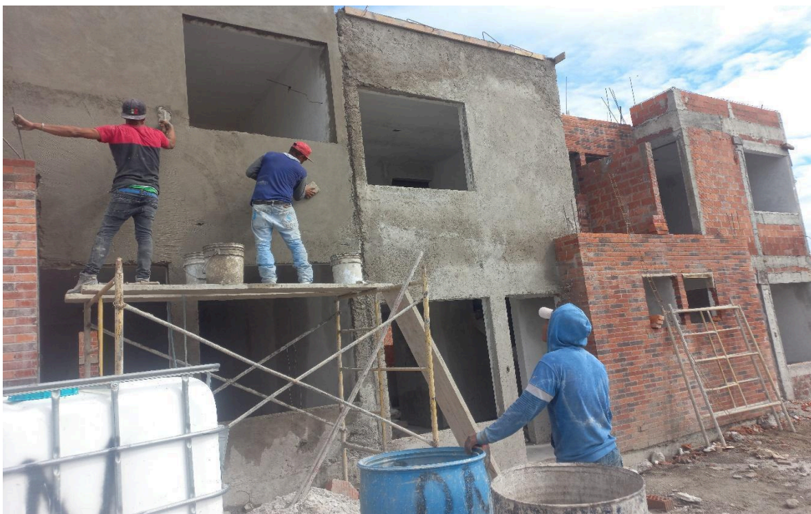
Foto 31: Proceso del aplanado. Xochitepec, Mor., Cristian Salas Juárez, 2023.
