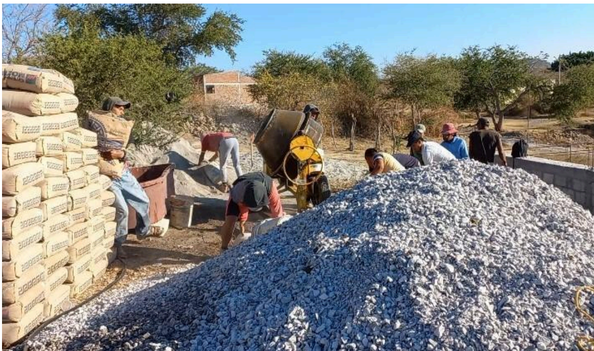
Foto 11: Los monstruos trabajando un “colado” de una losa. Xochitepec, Mor., Cristian Salas Juárez, 2022.
