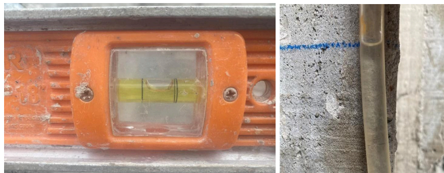
Foto 6 y 7: Los niveles deben de estar a la misma altura para que no se presenten errores de edificación. Xochitepec., Cristian Salas Juárez, 2023.
