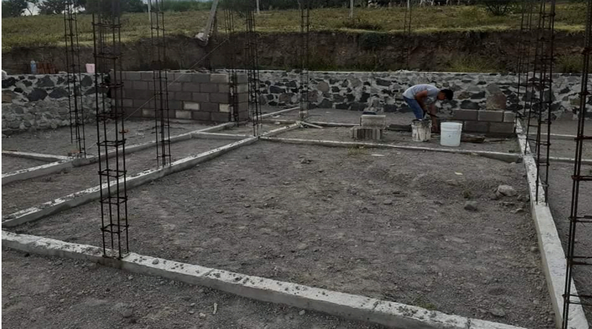
Foto 18: El mai Amado ha comenzado a levantar los muros de una casa habitacional. Xochitepec, Mor., Cristian Salas Juárez, 2022.
