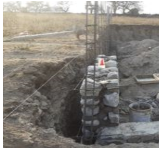
Fotos 2 y 3: Los hilos marcan los límites (línderos) de la obra o el tramo que se construirá. Xochitepec, Mor., Cristian Salas Juárez, 2022.
