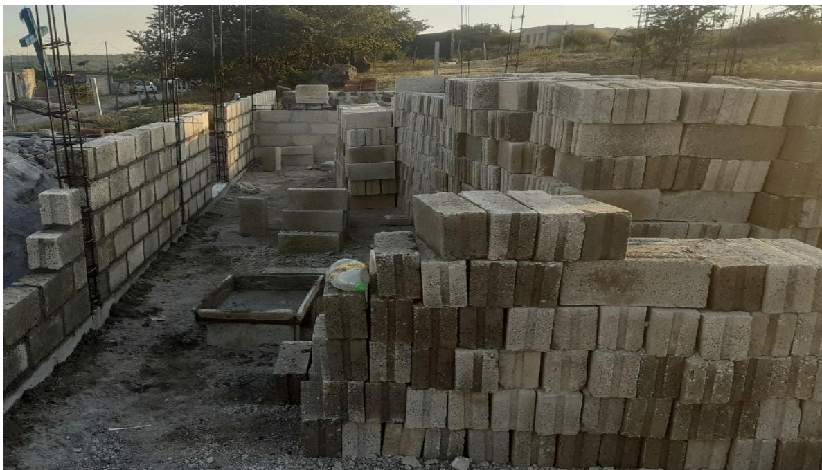
Foto 47: La soledad de la obra el 3 de mayo. Xochitepec, Mor., Cristian Salas Juárez, 2023.
