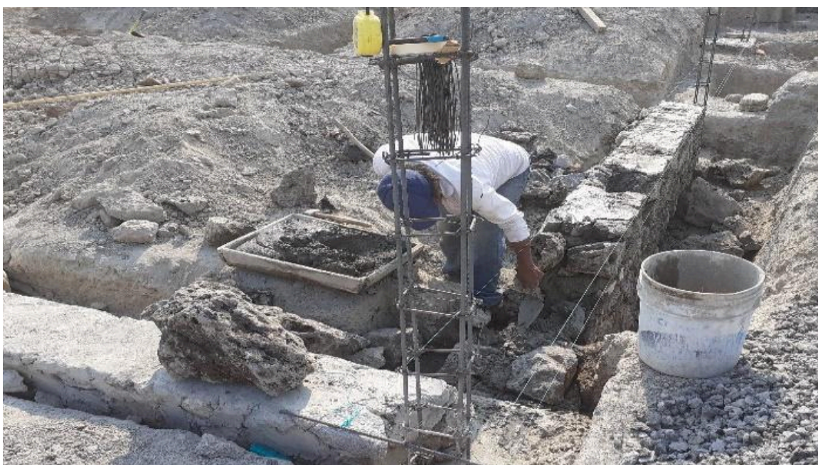
Foto 16: Don Geño pegando la mampostería de una casa/habitacional. Xochitepec, Mor., Cristian Salas Juárez, 2022.
