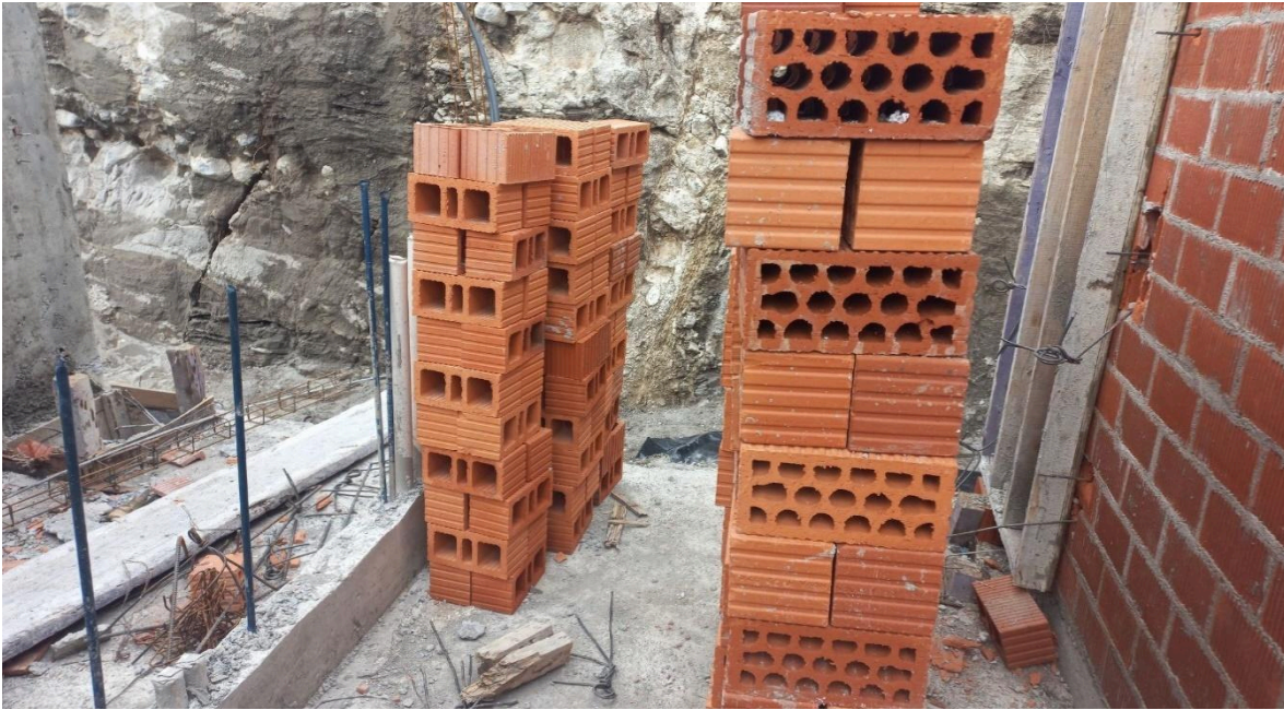
Foto 42: Los tabiques Interceramic que utilizan los albañiles para construir los condominios HABIZA. Xochitepec, Mor., Cristian Salas Juárez, 2022.
