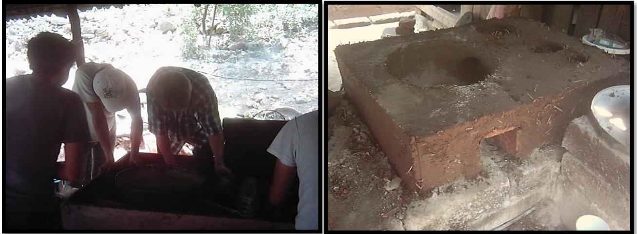
Figura 17. Construcción de estufa ahorradora de leña Tlecalli
