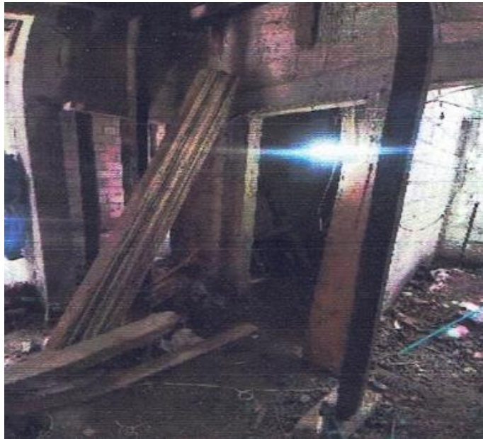
Ilustración 20. Retiro de cimbra de losa maciza. (18.952114, -98.979683).
