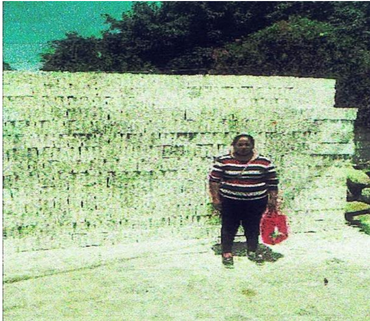
Ilustración 15. Inicio de obra con material. (18.952114, -98.979683).
