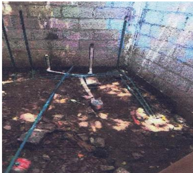
Ilustración 21. Instalación de instalaciones hidrosanitarias. (18.952114, -98.979683).
