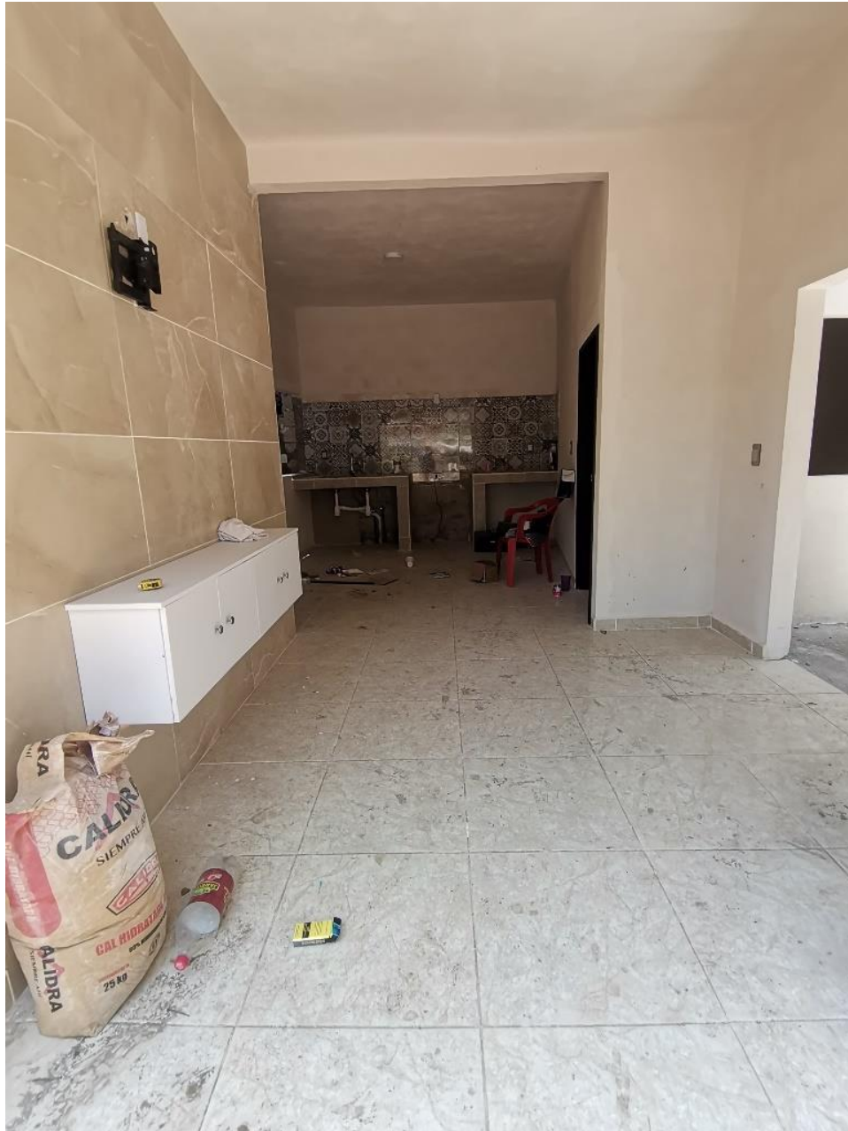
Ilustración 24. Revisión de instalaciones, acabados y detalles. (18.952114, -98.979683).
