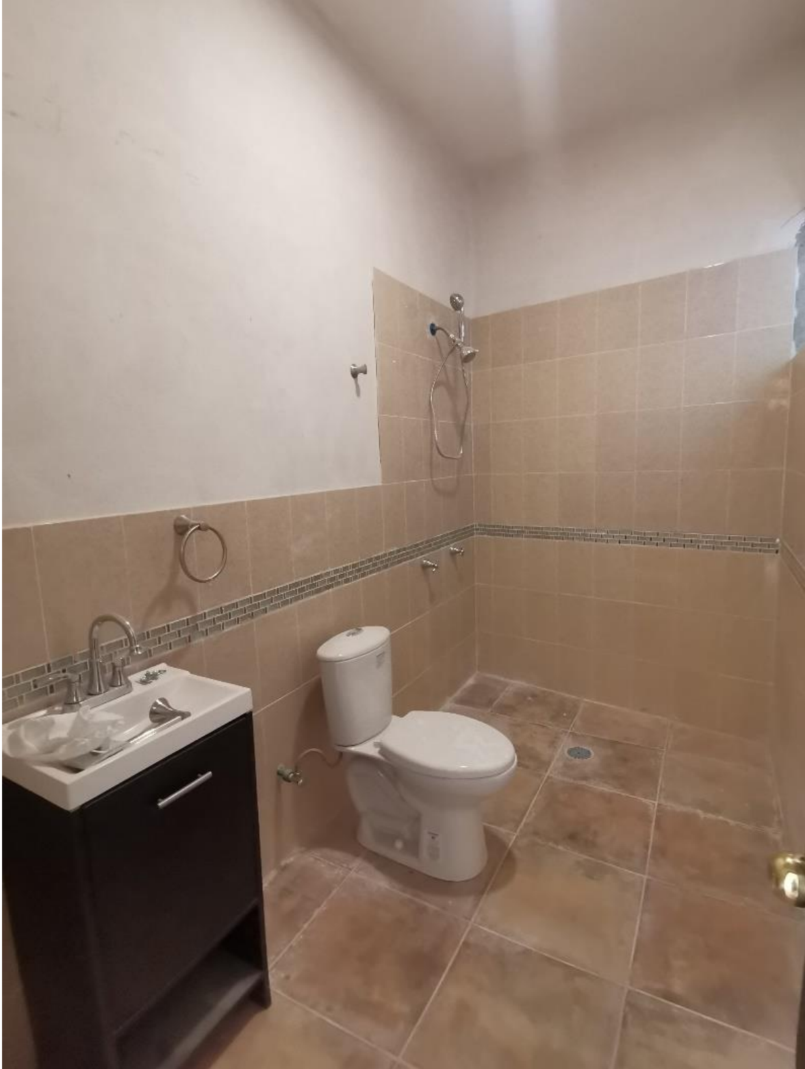
Ilustración 26. Revisión de instalaciones, acabados y detalles. (18.952114, -98.979683).
