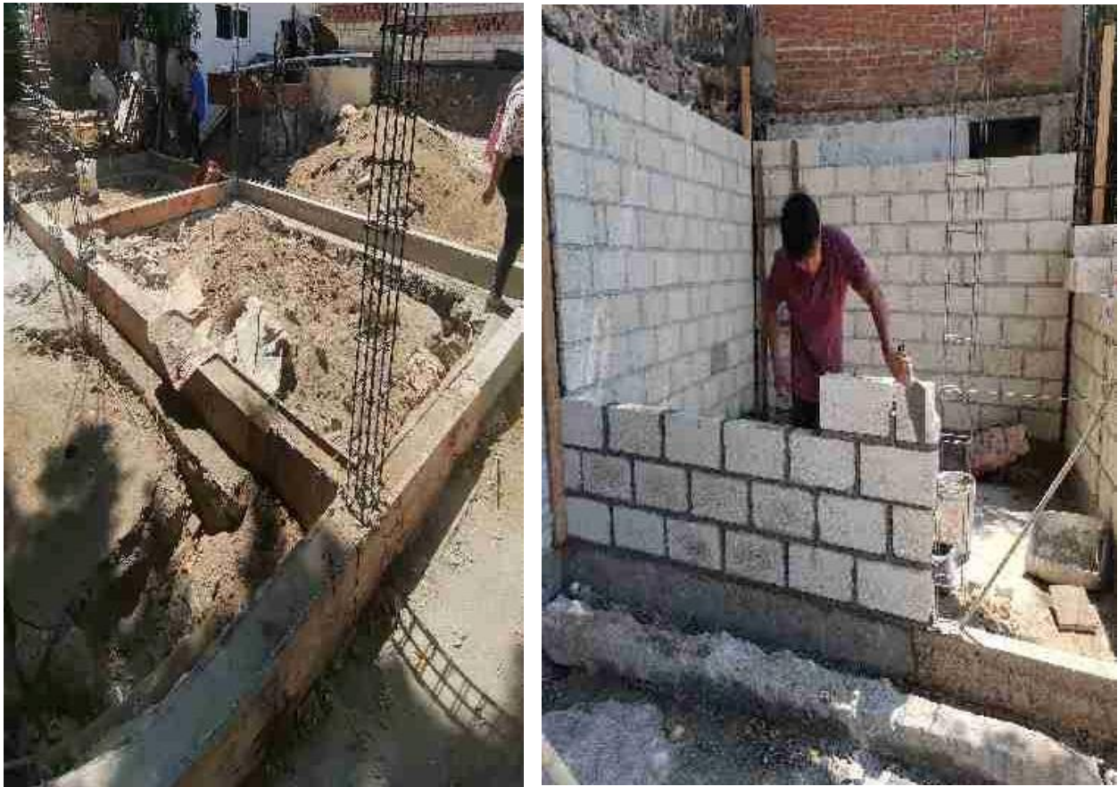
Ilustración 17. Avance con muros de block y cadena de desplante. (18.952114, - 98.979683).
