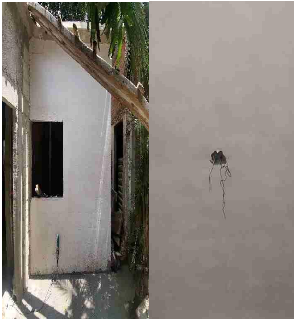
Ilustración 22. Avance de aplanado e instalaciones eléctricas. (18.952114, -98.979683).
