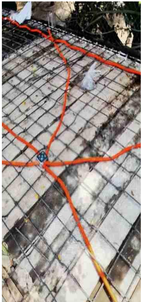
Ilustración 19. Losa maciza preparada para el colado. (18.952114, -98.979683).
