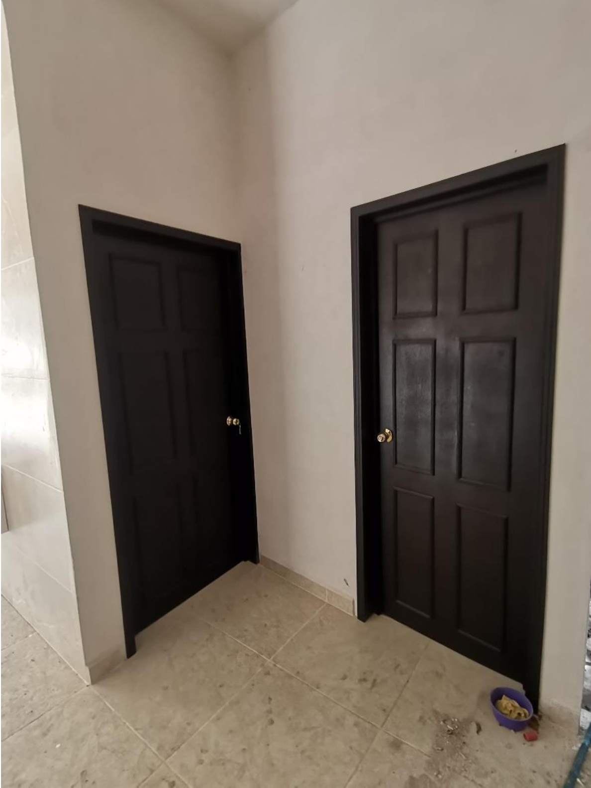
Ilustración 27. Revisión de instalaciones, acabados y detalles. (18.952114, -98.979683).
