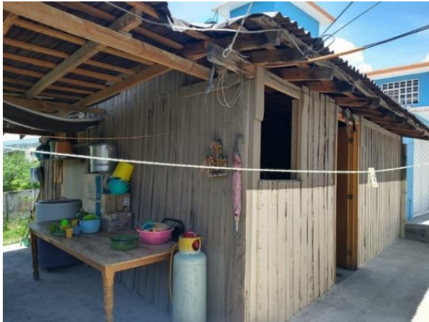
Imagen 27. Vivienda Emergente 1, Fachada
