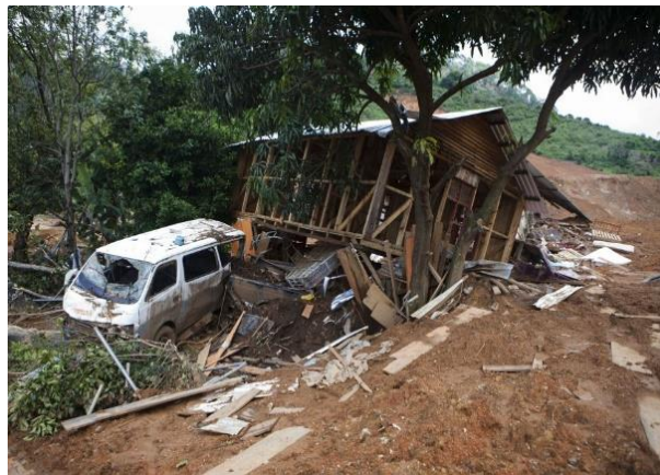
Imagen 17. Vivienda destruida en la Pintada.
