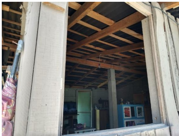
Imagen 29. Vivienda Emergente 1 interior
