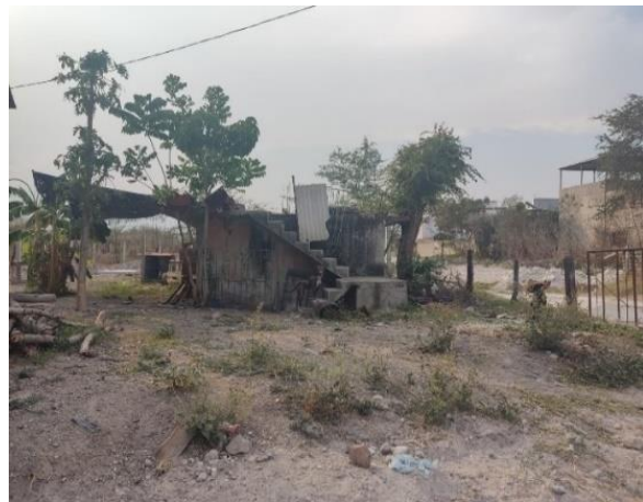
Imagen 45. Construcciones abandonadas cercanas al río
