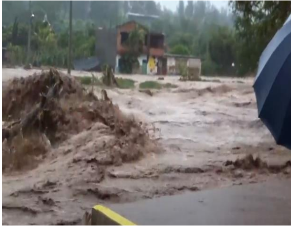
Imagen 23. Derrumbe de Puente 2 en Petaquillas
