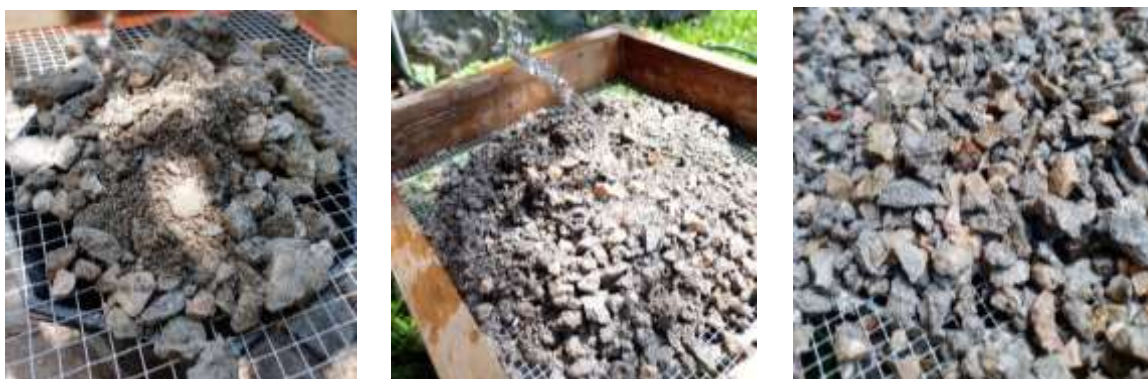
Figura 22. Selección de material por medio de cribado y limpieza de los mismos.
