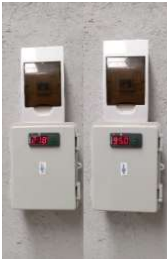
Figura 25. Indicador de temperatura ( 21.8\text{ }^{\circ}\text{C} ) y humedad (95%) al interior del cuarto.
