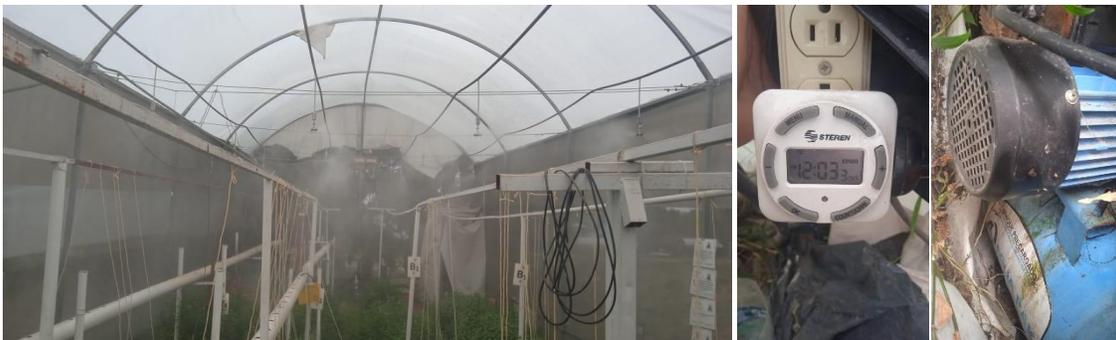
Figura 22. Sistema de nebulización presurizado para el manejo de altas temperaturas en el invernadero
