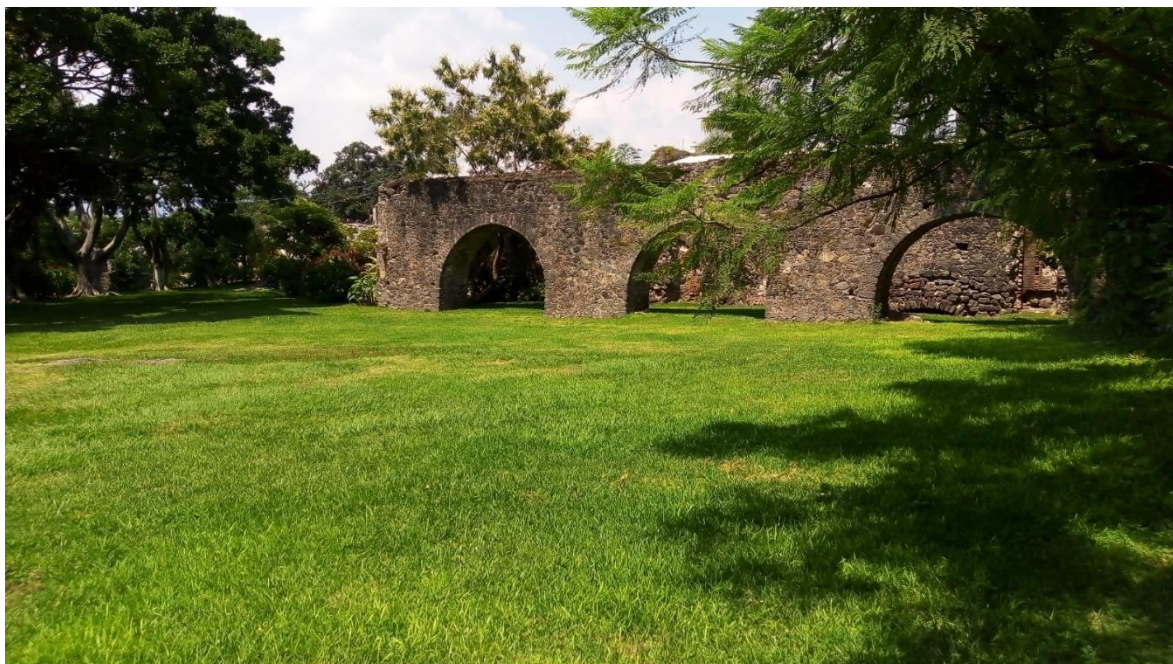
3.13 Antiguo acueducto de la San Gaspar, Juitepec, 14 de octubre 2022, fotografía tomada por Juan Rey Santiago
