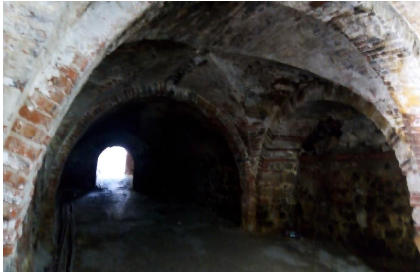
3.10 Antiguo corredor del casco hacia el patio atrás de la hacienda de San Vicente, Emiliano Zapata, 22 de septiembre 2022, fotografía tomada por Juan Rey Santiago
