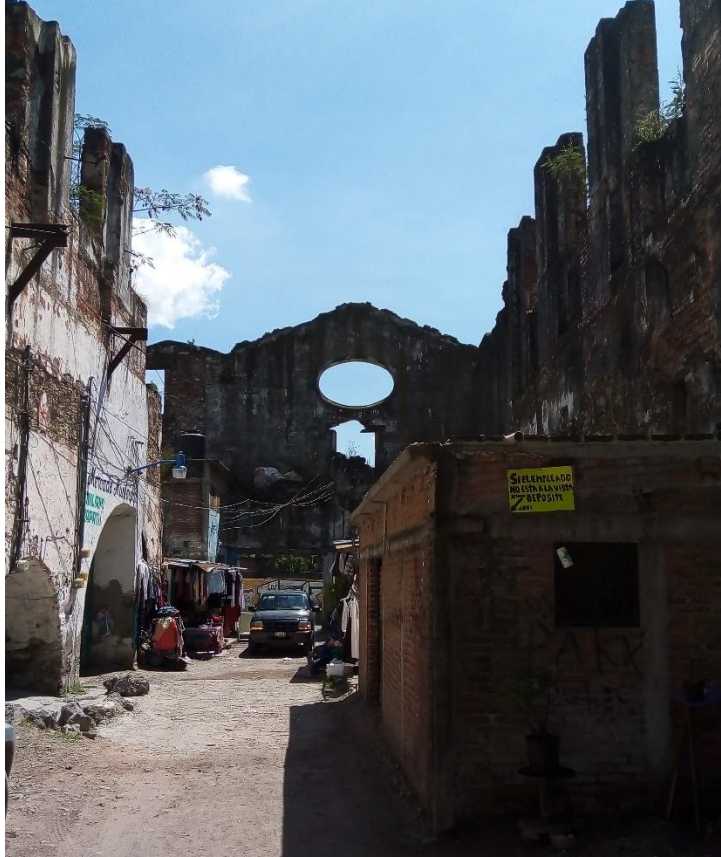
3.9 Antigua fábricas de la hacienda de San Vicente, Emiliano Zapata, 22 de septiembre 2022, fotografía tomada por Juan Rey Santiago
