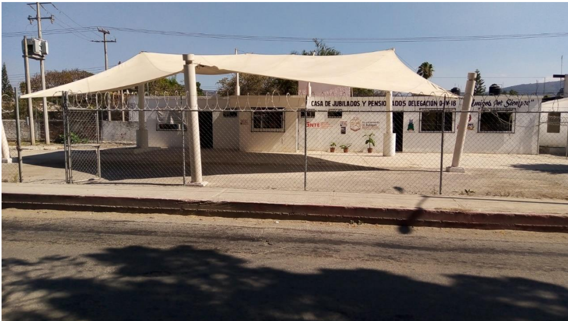
Fotografía 3.25 Casa de jubilados y pensionados, (antigua estación "El Mango") Jiutepec, 15 de Marzo 2022, foto tomada por Juan Rey Santiago.
