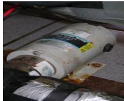
Figura 3.17 Bombas de la mezcla absorbente y agua condensada [Torres 2017].
