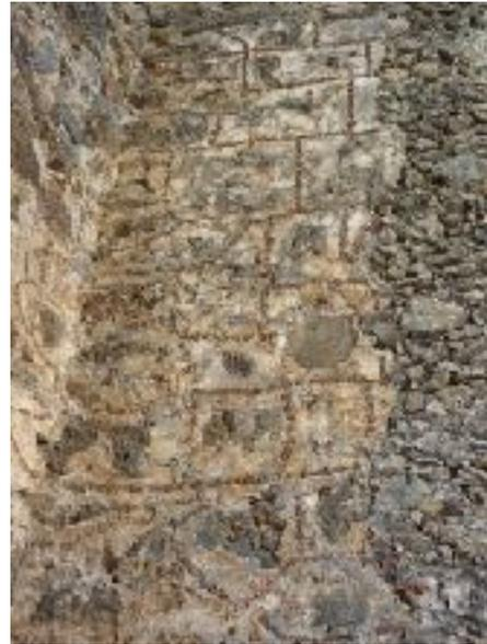
Imagen 92. En la imagen del lado izquierdo se observa con claridad el dibujo preparatorio inciso. Imagen 93. Por su parte en la imagen del lado derecho observamos los rejonés del muro norte. (Mateos, 2013).
