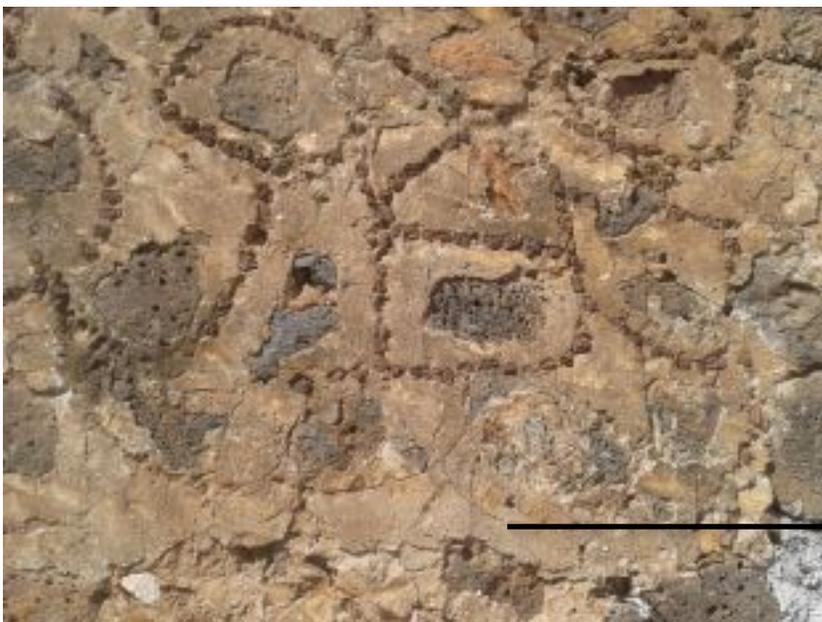
Figura 157. Esta foto de la Capilla de Santiago en Nepopualco, Totolapan se torna especialmente relevante, ya que es la que nos muestra este encintado con rejones y esgrafiados que guían la punción (mortero aplicado sobre las juntas para rediseñar el mamposteo) (Mateos, 2012).
