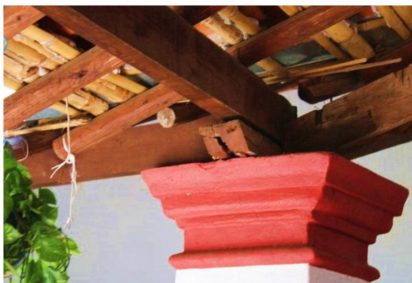
Imagen 73: Detalle de la colocación de la estructura de una techumbre sobre una columna en el de una vivienda tradicional Fotografía: Colección propia del autor
