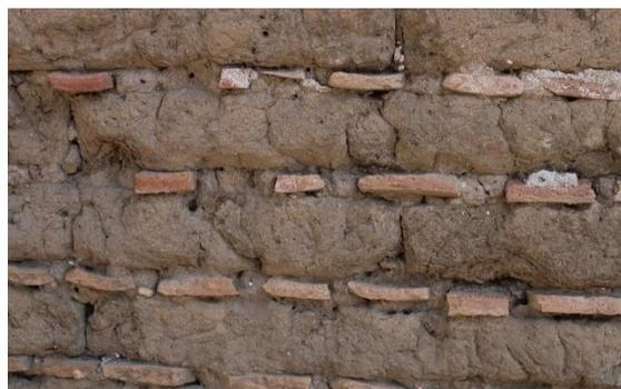
Imagen 64-65: Detalle de diversas tipologías de muros de adobe
