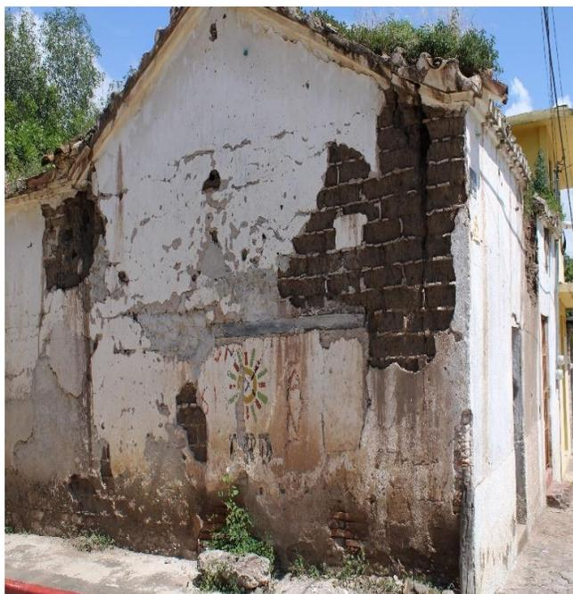
Imagen 72: Daños en fachadas causados por sismos en una vivienda tradicional Fotografía: Colección propia del autor
