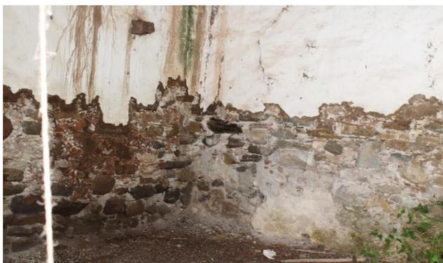
Imagen 67: Detalle de muros de mampostería con piedra
