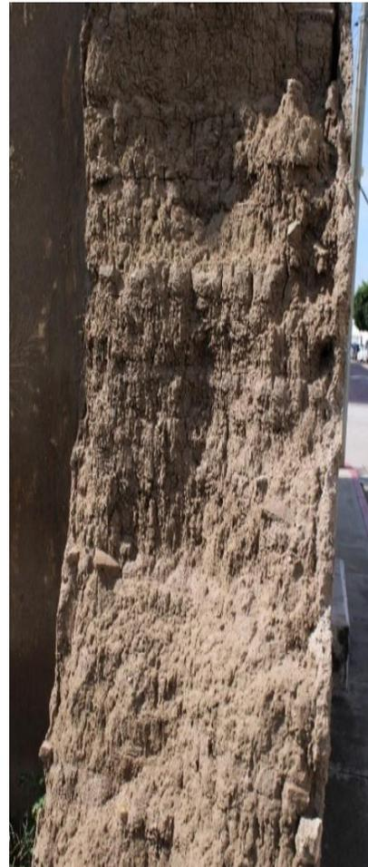
Imagen 63: Detalle del grosor de un muro de adobe de una vivienda tradicional
