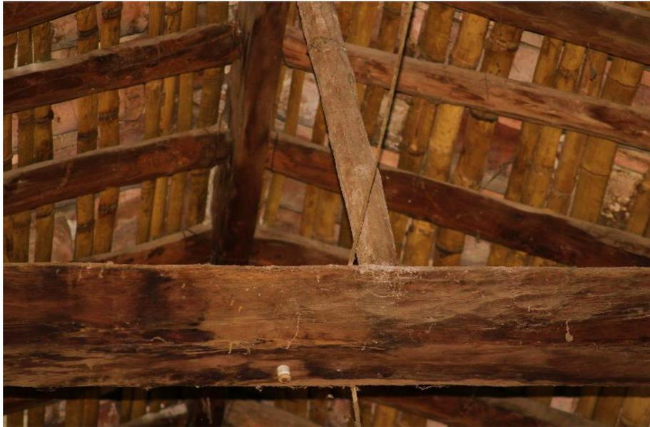
Imagen 26: Sistema constructivo tradicional de techados de las viviendas tradicionales en Tepecoacuilco Fotografía: Colección propia del autor
