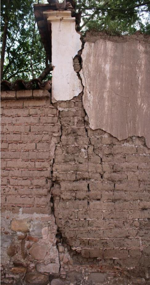
Imagen 68: Daños en muros por el paso del tiempo y sismos Fotografía: Colección propia del autor
