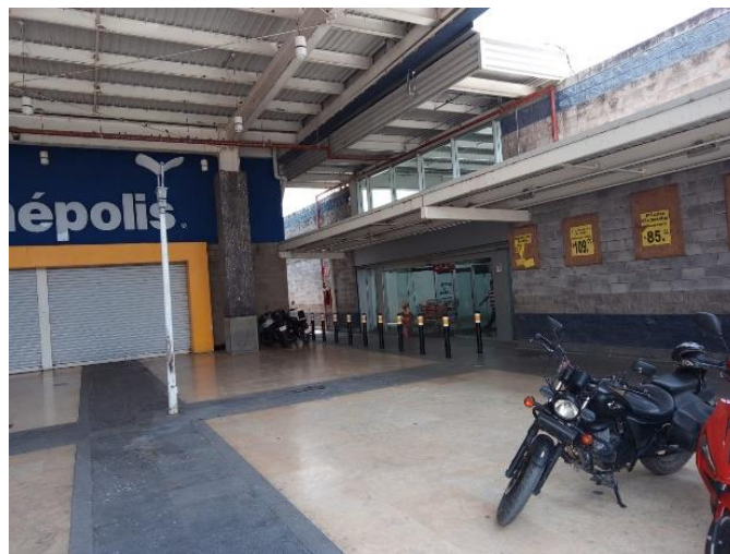
Figura 6. Entrada trasera orientada al oeste.
