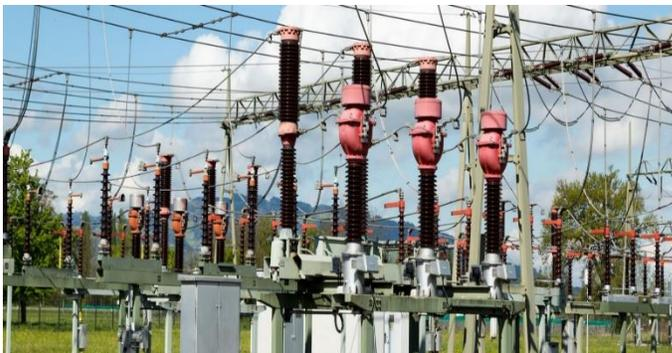
**Fig. 3.3 Transformadores de Instrumento en subestación.**
