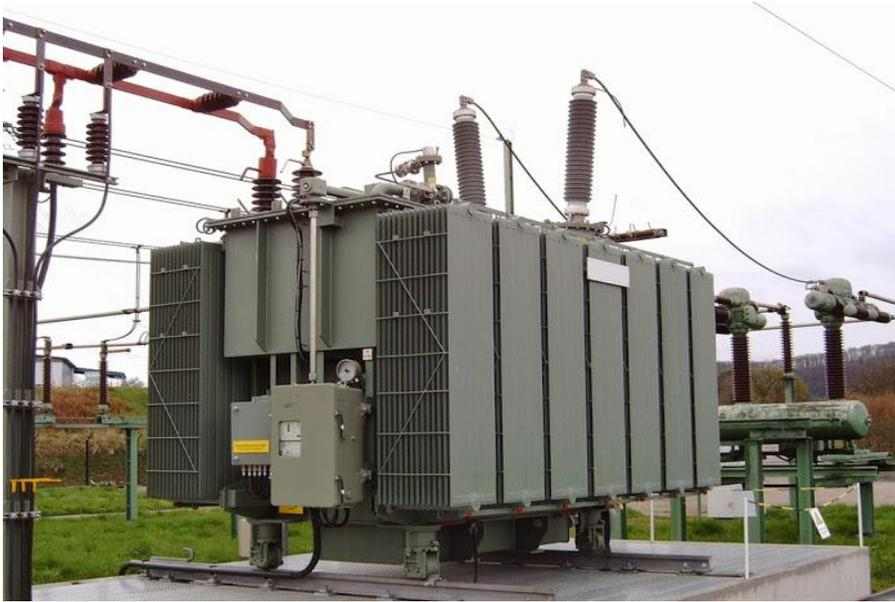
**Fig. 3.1 Transformador de potencia.**
