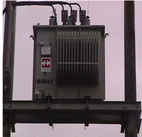
**Fig. 3.18 Transformador de Servicios propios o Servicio de Estación.**
