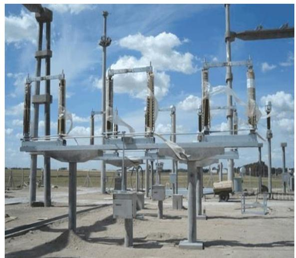
**Fig. 3.11 Cuchilla de Apertura Vertical.**
