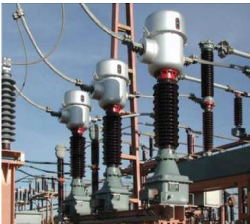
**Fig. 3.7 Transformador de Corriente.**
