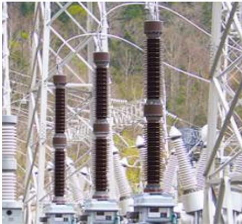
**Fig. 3.6 Transformador de potencial Capacitivo.**
