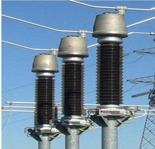
**Fig. 3.4 Transformador de potencial.**
