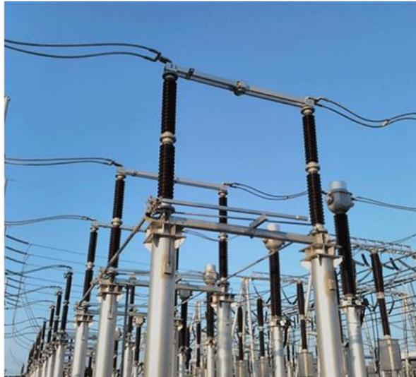
**Fig. 3.13 Cuchilla de Apertura Horizontal Central.**
