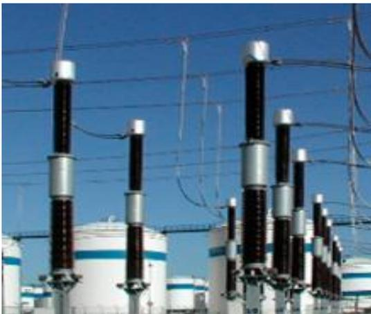
**Fig. 3.5 Transformador de potencial Inductivo.**
