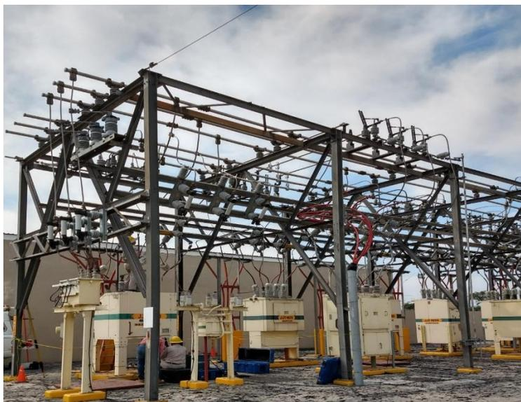
**Fig. 3.2 Interruptores de Potencia.**
