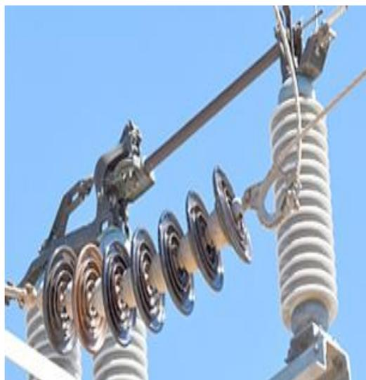
**Fig. 3.21 Aislador Tipo Suspensión de porcelana.**
