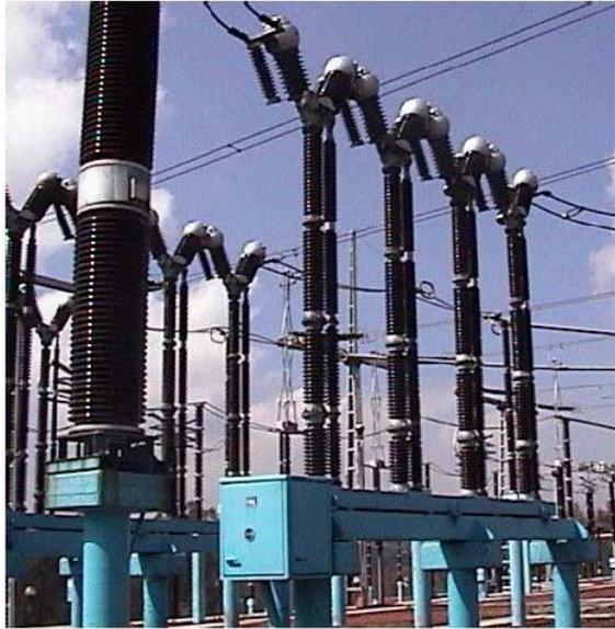
**Fig. 4.10 Arreglo de interruptores de PVA con multicámara**
