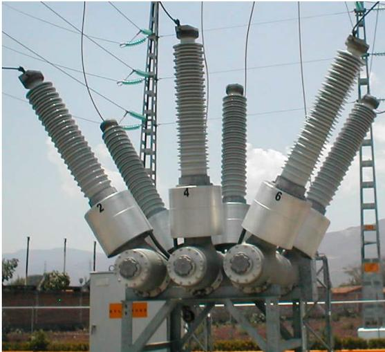
**Fig. 4.16 interruptor en SF6 de tipo intemperie de tanque muerto.**
