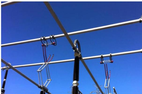
**Fig. 3.10 Cuchilla Pantógrafo o Tijera.**
