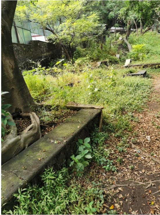
Fig. 101. Antes de la limpieza. Fuente: autora.
