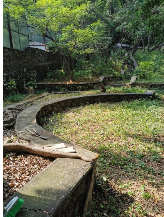
Fig. 102. Después de la limpieza. Fuente: autora.
