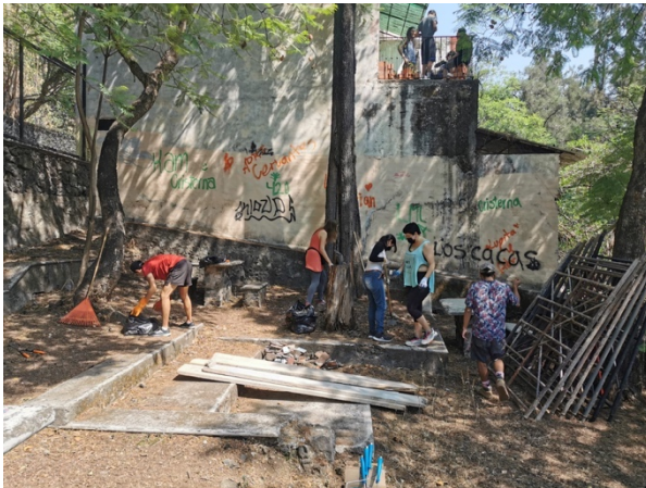
Fig. 103. Pared del mural antes de la intervención. Fuente: autora.
