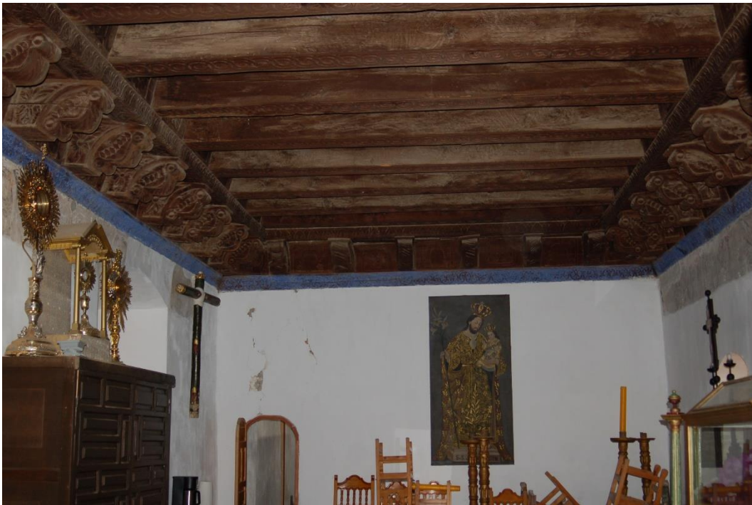
Fotografía 9 Sacristía, detalle del alfarje de madera, autor, sept 2017.
