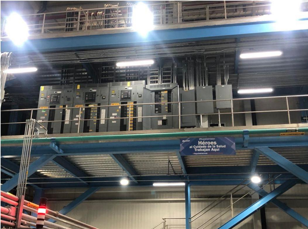
Foto 6 tableros de distribución 440, 220/127, VCA, instalados dentro de planta
