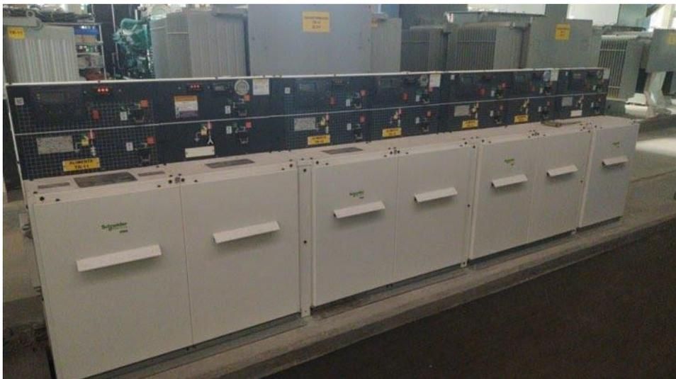
Foto 2 equipo RM6 (derivaciones para alimentar cada transformador)
