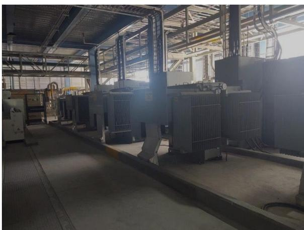
**Foto 3- Transformadores ubicados en nueva subestación.**
