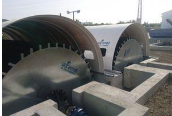
Figura 2.17 Los contactores biológicos rotativos (biodiscos) son una tecnología diseñada para procesos aerobios.
