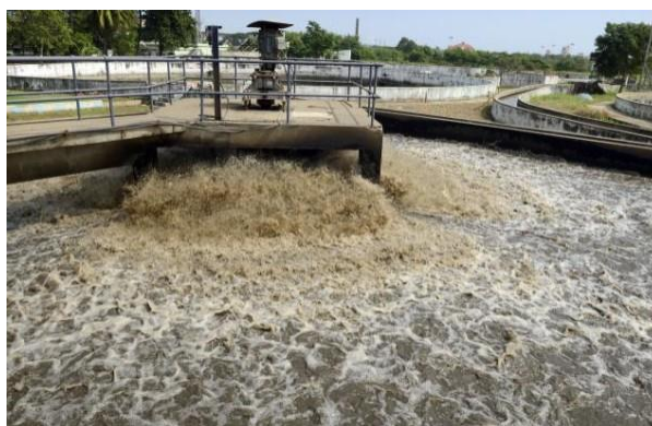
Figura 2.14 El tratamiento de las aguas residuales es de vital importancia para un mayor aprovechamiento del recurso.
