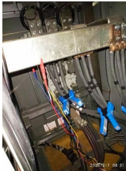
*Figura 4.1. Conexión de sensores para tensión y corriente.*
