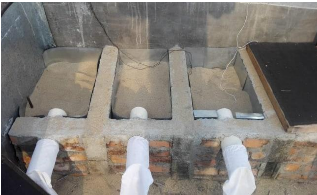
Fig. 4. Cámaras de desove para la recolección de huevos. Construidas con tabiques y cemento.
