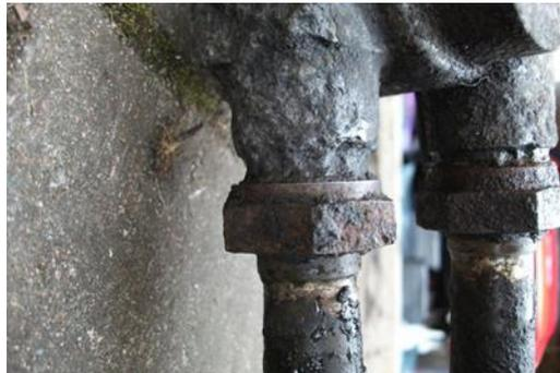
*Figura 2.18 Corrosión galvánica.*
