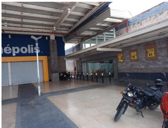
Figura 6. Entrada trasera orientada al oeste.
