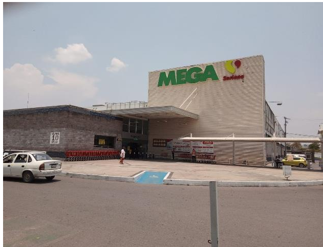
Figura 5. Entrada principal orientada al este.
