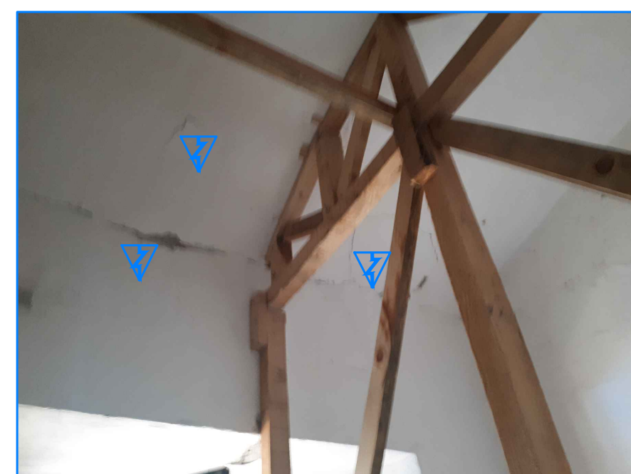
Ilustración 1 y 2. Intrados de bóveda
