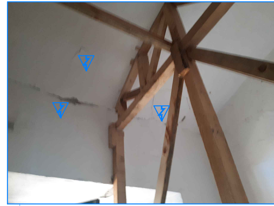
Ilustración 1 y 2. Intrados de bóveda
