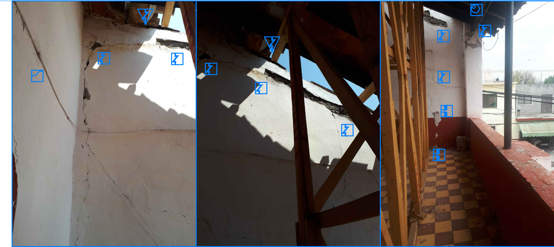
Ilustración 4, 5 y 6. Contrafuertes
