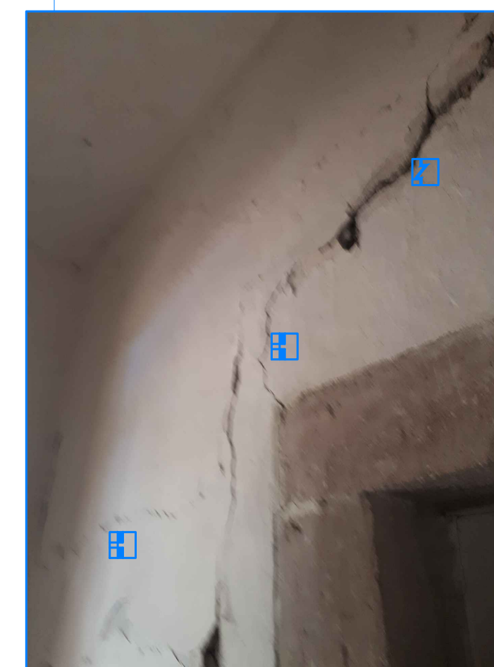
Ilustración 5. Vano Tapiado
