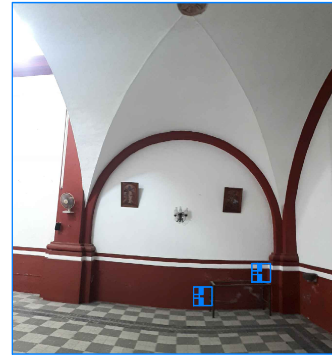
Ilustración 1 Muro sotocoro, lado Sur.
