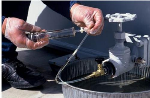
Figura 2.14 Válvula De Drenaje
