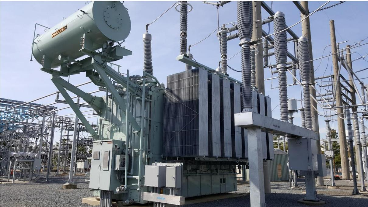
Figura 2.1 Transformador De Potencia
