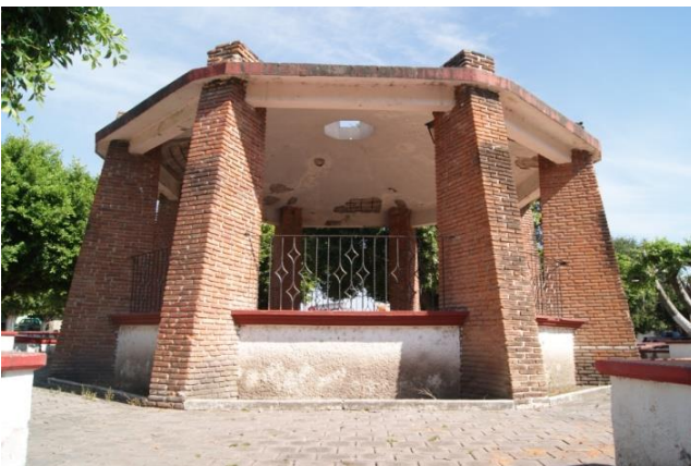
Fachada frontal del kiosco. Fotografía Miguel Angel Gaona Aguilar- Rogelio Bahena Miranda 2015.
