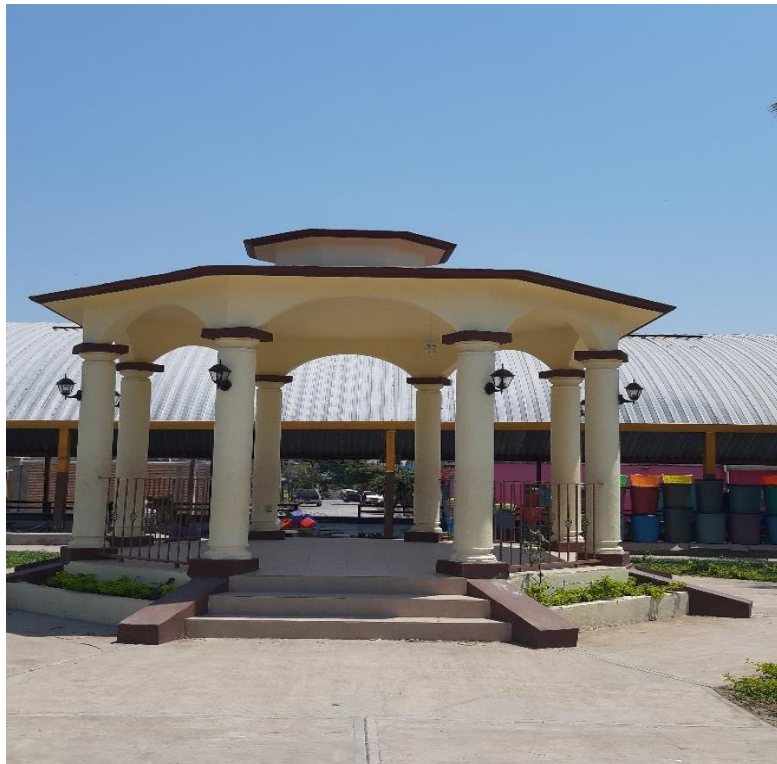
Etapas de construcción del kiosco. Fotografía Miguel Angel Gaona Aguilar-Rogelio Bahena Miranda 2015.
