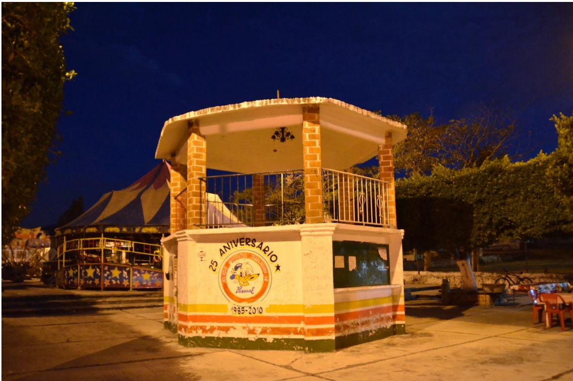
El antiguo kiosco de El Rodeo. Fotografía Arq. Juan Eduardo Cruz Archundia.
