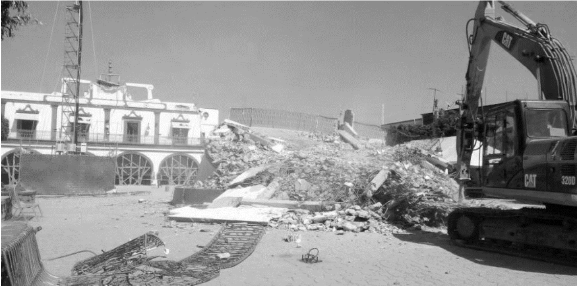
Demolición del kiosco en diciembre del 2017. Fotografía Cadena Sur Multimedia.
