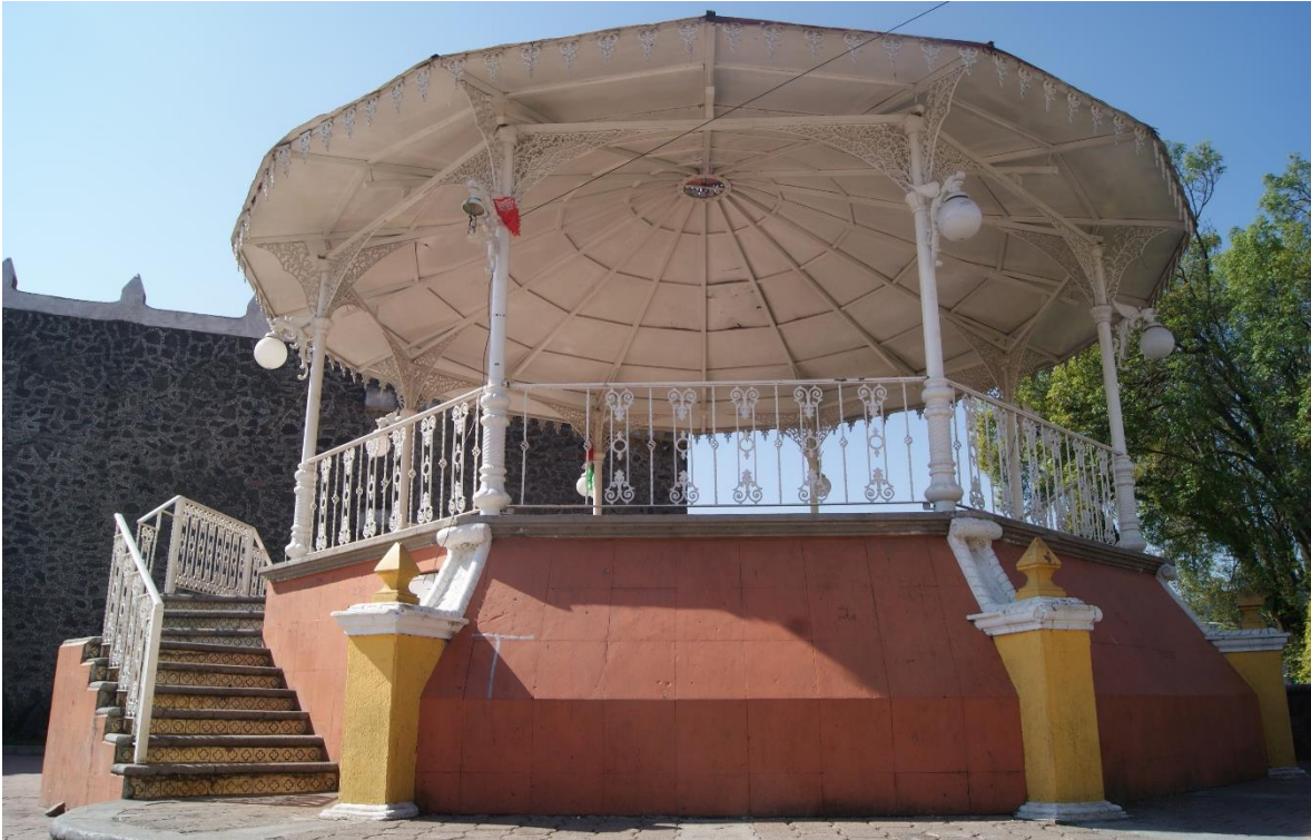
Detalles del kiosco. Fotografía Miguel Angel Gaona Aguilar- Rogelio Bahena Miranda 2015.
