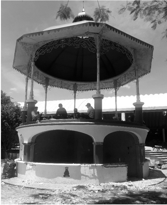
Trabajos de demolición del kiosco. Fotografía Miguel Angel Gaona Aguilar- Rogelio Bahena Miranda 2018.
