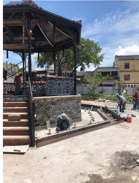
Detalles constructivos de la base y escaleras del nuevo kiosco. Fotografía Miguel Angel Gaona Aguilar- Rogelio Bahena Miranda 2020.
