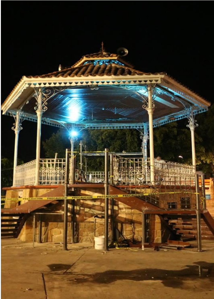
Trabajos de remodelación en el kiosco. Fotografía Miguel Angel Gaona Aguilar- Rogelio Bahena Miranda 2015.
