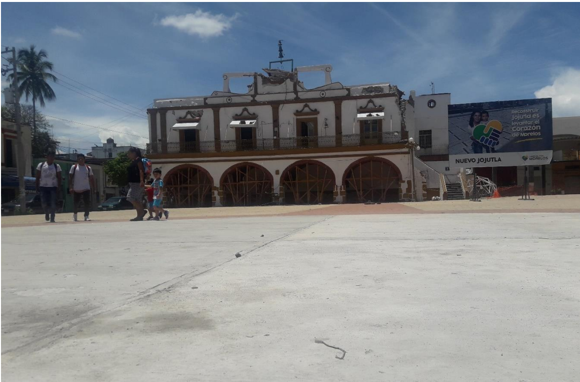
La plaza en obras para el inicio de una nueva transformación. Fotografía Miguel Angel Gaona Aguilar- Rogelio Bahena Miranda 2018.
