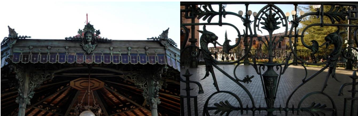
Cubierta y barandal. Fotografías tomadas del INAH CHIHUAHUA
