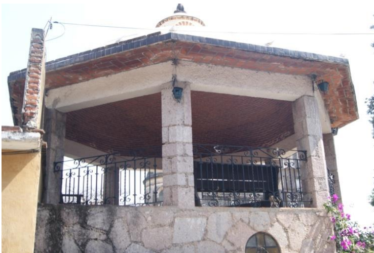
Detalles del kiosco de Santo Domingo. Fotografía Miguel Angel Gaona Aguilar- Rogelio Bahena Miranda 2015.
