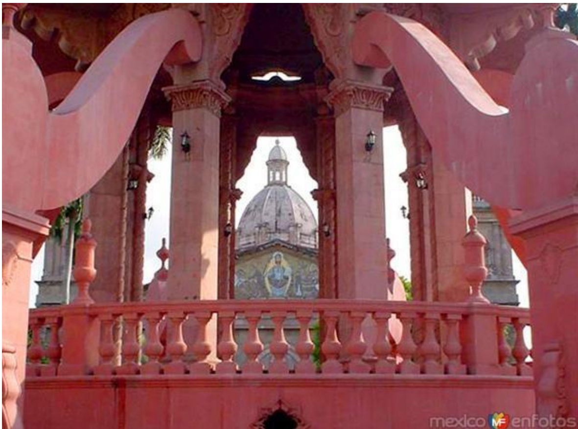
Detalles de columnas y contrafuertes. Fotografía de México En Fotos
