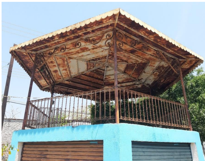
Detalle de la cubierta. Fotografía Miguel Angel Gaona Aguilar-Rogelio Bahena Miranda 2015.
