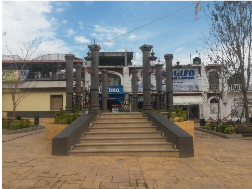
Etapa constructiva del kiosco. Fotografía Miguel Angel Gaona Aguilar- Rogelio Bahena Miranda 2015.
