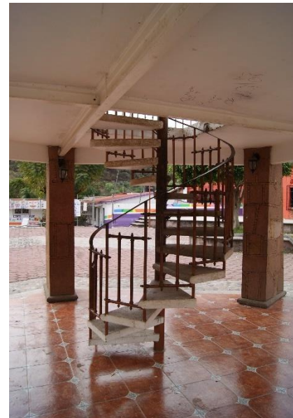
Detalle de escaleras al interior del kiosco. Fotografía tomada por Miguel Angel Gaona Aguilar- Rogelio Bahena Miranda 2015.
