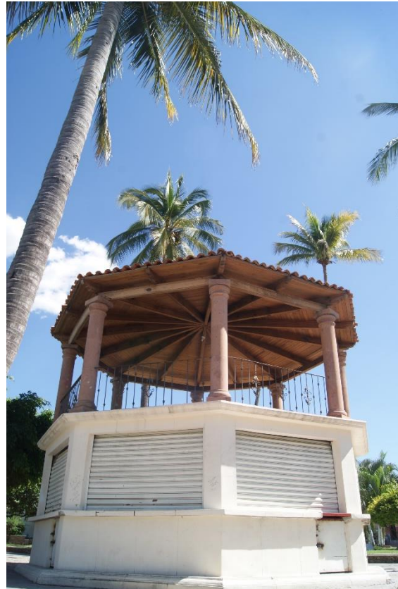
Detalles del kiosco. Fotografía Miguel Angel Gaona Aguilar- Rogelio Bahena Miranda 2015.
