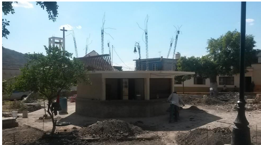
Trabajos de remodelación. Fotografía Miguel Angel Gaona Aguilar-Rogelio Bahena Miranda 2015.
