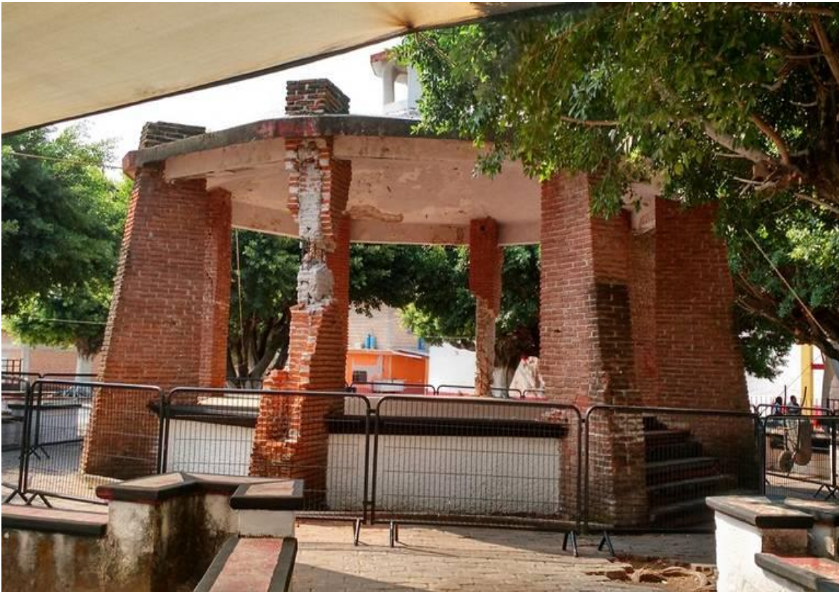
Danos de kiosco por el temblor del 2017. Fotografía El sol de México 2017
