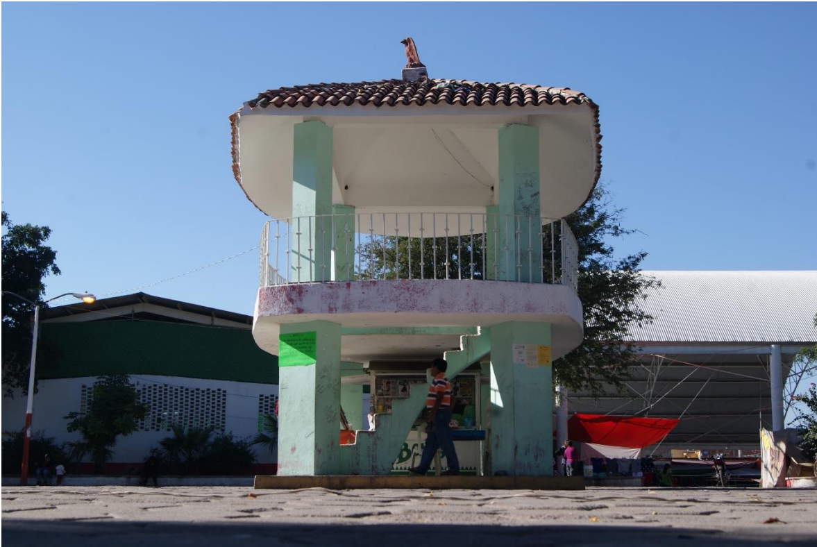
Fachada principal del kiosco de Xoxocotla, Mor. Fotografía Miguel Angel Gaona Aguilar- Rogelio Bahena Miranda 2015.
