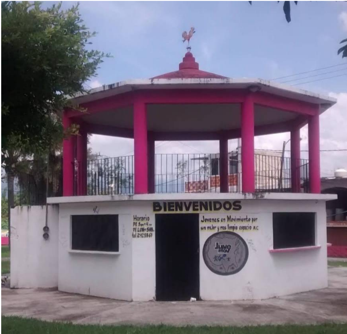
Vista principal del kiosco. Fotografía Fernando Nieto.
