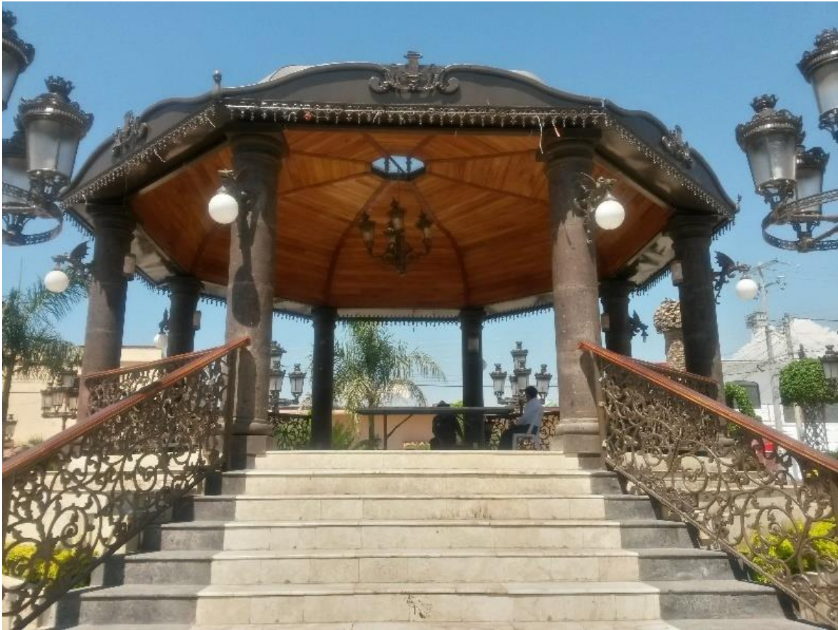
Fachada frontal del kiosco. Fotografía Miguel Angel Gaona Aguilar- Rogelio Bahena Miranda 2015.
