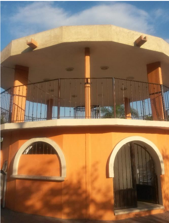
Detalles del kiosco. Fotografía Miguel Angel Gaona Aguilar- Rogelio Bahena Miranda 2015.
