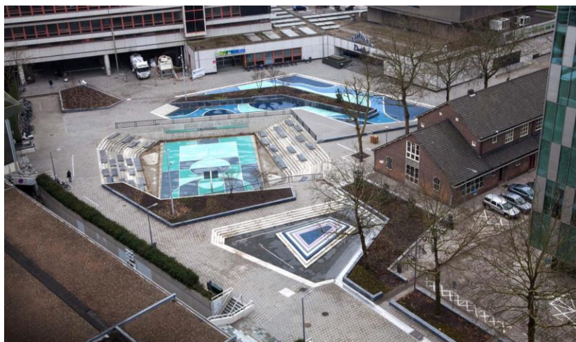
Imagen 9 , Plaza De Agua Bentheplein después de intervención Fuente: urbanisten.nl/wp/wp-content/uploads/paisea_024.pdf
