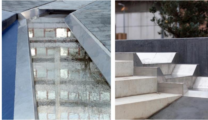
Imagen 10, Plaza De Agua Bentemplein canales de captación de lluvia. Fuente: publicspace.org
