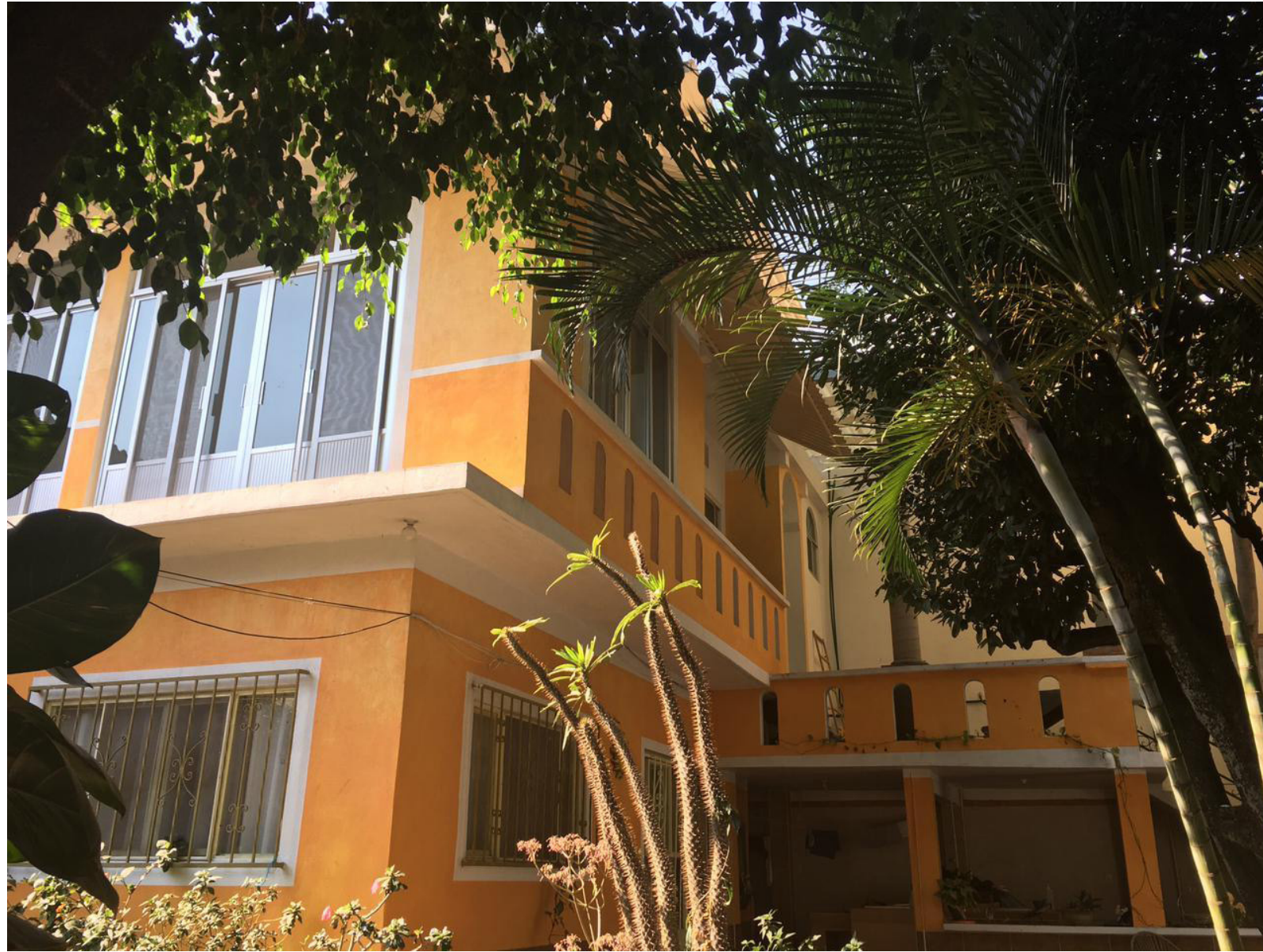
Casa Mora Vista del patio y de la construcción principal 2021
