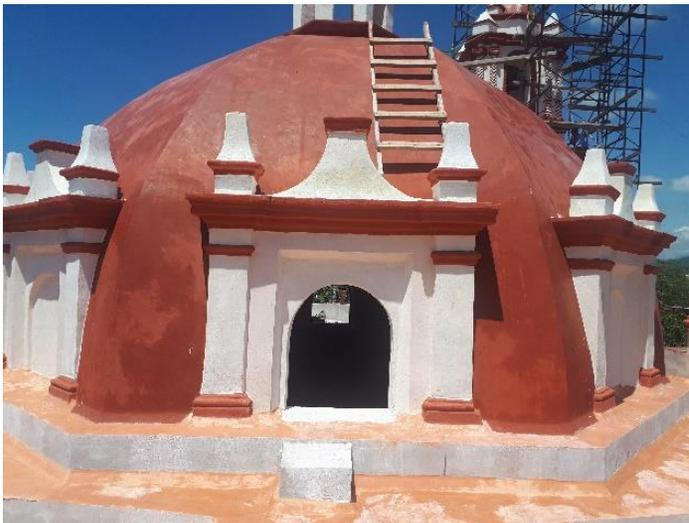
**Fotografía 33. Integración de impermeabilizante en extradós de cúpula a base de cal-alumbre agregando pigmentos naturales en extradós de cúpula. Tomada por autora. Año 2019**
