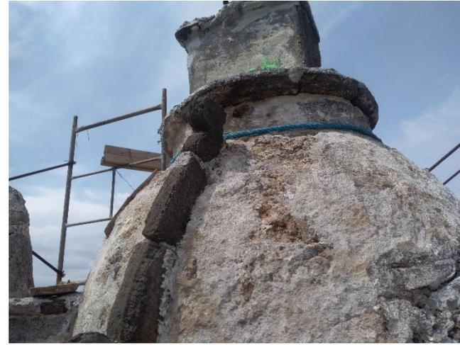
**Fotografía 46 Liberación de aplanados de cemento en cúpula de torre campanario. Tomada por autora. Año 2018**
