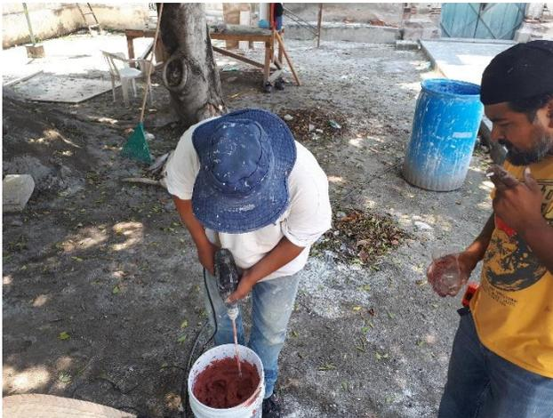
Fotografía 62 Batido de pigmentos, para obtener mezcla homogénea de pintura a la cal. Tomada por autora. Año 2019
