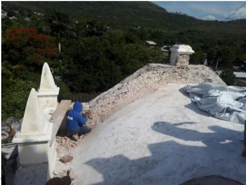
**Fotografía 37. Liberación de aplanados en muros de pretil. Tomada por autora. Año 2018**
