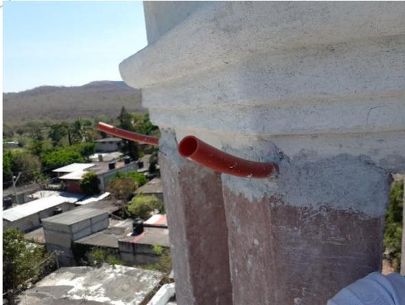
**Fotografía 32. Consolidación de grieta en columnas de linternilla en extradós de cúpula. Tomada por autora. Año 2019**
