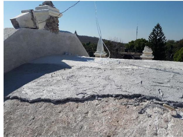
Fotografía 41. Integración de capa de compresión en extradós de bóveda.
