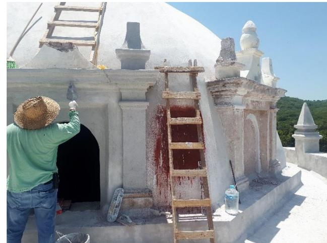
**Fotografía 31. Integración de aplanado fino, acabado bruñido en extradós de cúpula. Tomada por autora. Año 2019**
