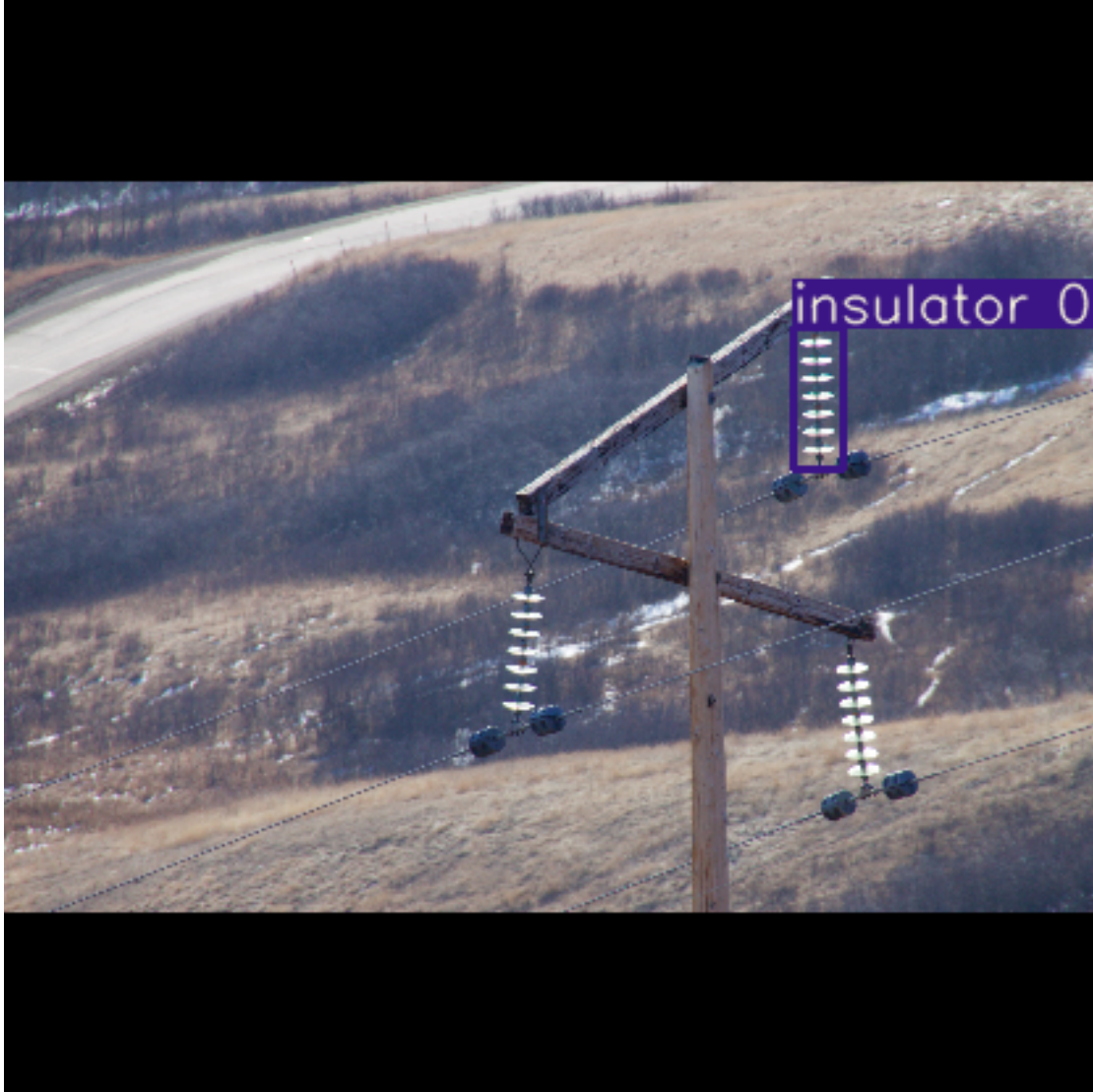
Figura 5.7: Caso de aisladores eléctricos no detectados con el modelo YOLOv3 entrenado
