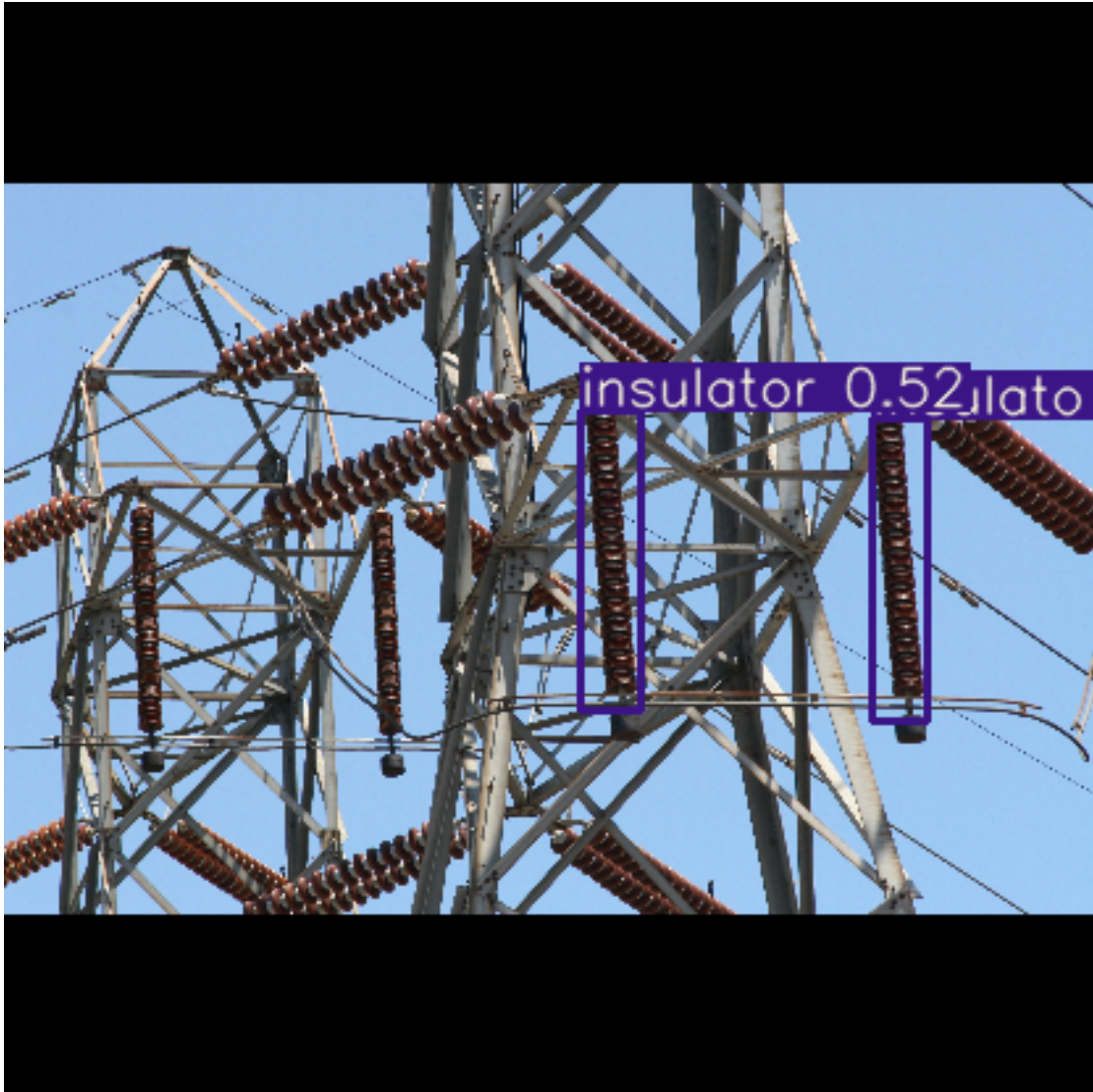
Figura 5.10: Caso real con cadenas de aisladores dobles
