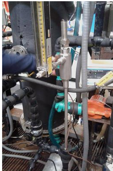
Figura 5.6 Instalación de Celda de Conductividad Eléctrica
