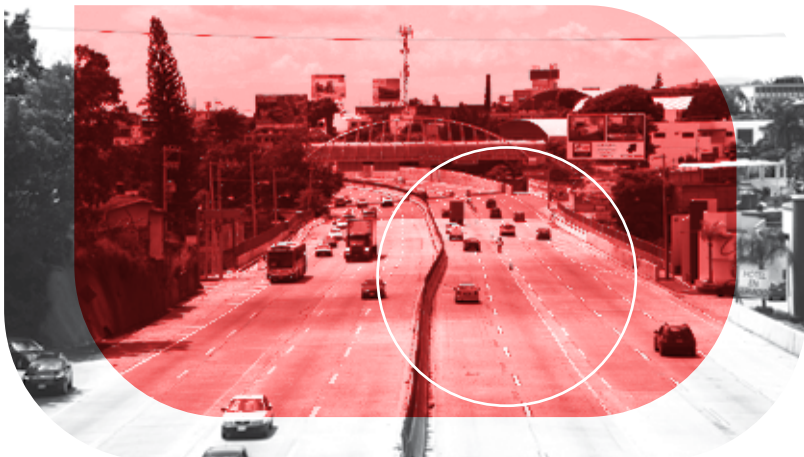
FIGURA 11. Carriles mal trazados.
