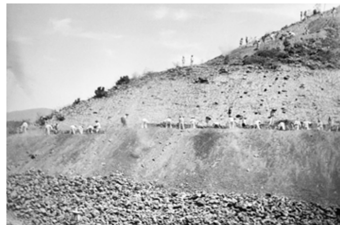
Trabajos de reconstrucción en Teotihuacan
