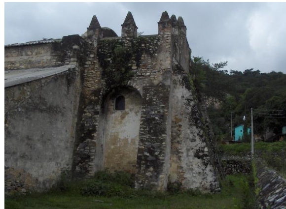
3.21.- Ábside de la iglesia de San Juan Bautista de Coxcatlán, Gro. Se distingue claramente en esta imagen la capilla abierta de la primera mitad del siglo XVI, ahora Presbiterio de la iglesia. Fot. del Autor, 2010.
