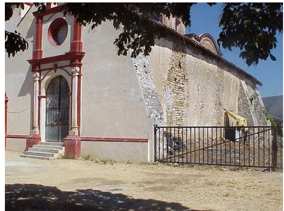
3.32.- Iglesia antigua de Tecapulco, en el muro sur se observa el sistema constructivo prehispánico: piedra tipo laja asentada con lodo. Fot. del autor, 2005.
