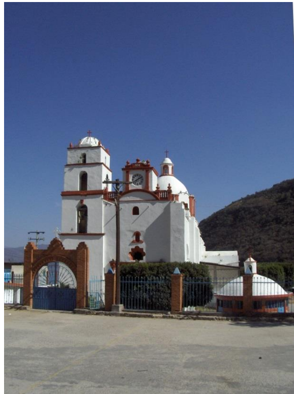
3.40.- Iglesia de San Francisco de Cuatepec de los costales, del municipio de Teloloapan. Fotografía del autor, 2009.
