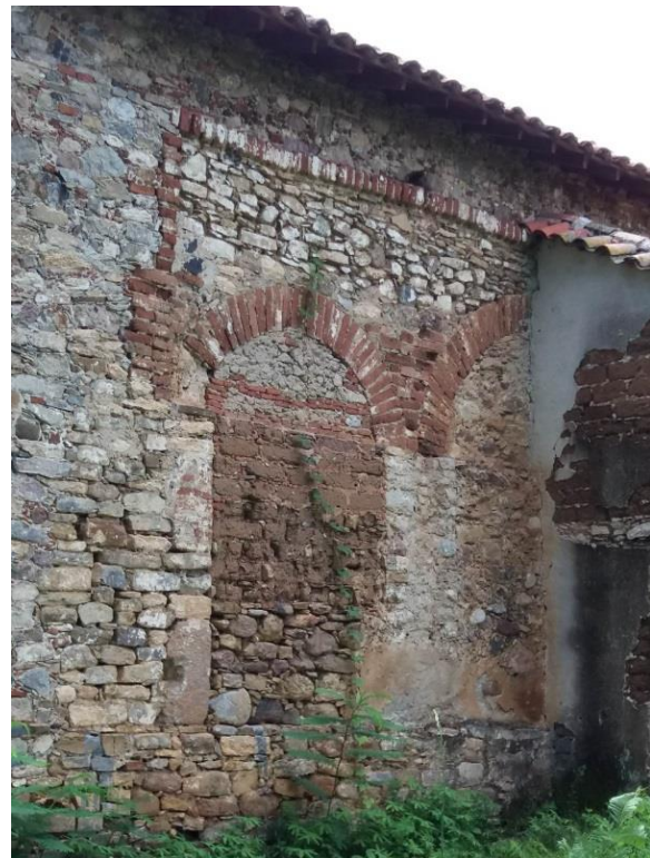
Fig. 3.11.- Detalle fachada poniente de la Capilla de San Sebastián, Guerrero, donde muestra la entrada de la capilla abierta que una vez lo fue. Fot. del autor, 2017.
