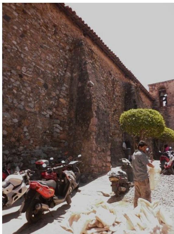
Fig. 3.37- Muro norte de la iglesia de San Nicolás Tolentino. Al centro, del lado Izquierdo, aparece un contrafuerte inmerso en el muro cabecero, mismo que sostenía al muro cabecero de la iglesia primitiva. Fotografía del autor, 2012.
