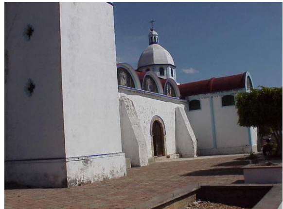
3.39.- Iglesia de San Francisco de Ixcapuzalco Gro. Fotografía del autor, 2008.
