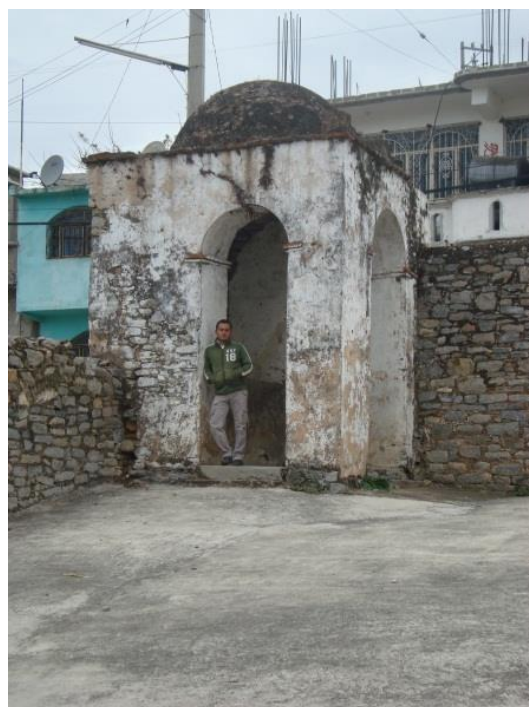
5.1.- Capilla posa en el atrio de la iglesia de Chilacachapa, Gro., destruida a finales del año 2010. Fotografía del autor, 2010.
