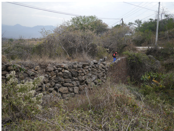
Figura 1.7.3 Muro de contención del puente virreinal. Camino real Cuernavaca-Yautepec
