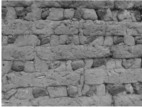
Figura 1.1.5 Muros de adobe de la vivienda tradicional de Totolapan, Morelos
