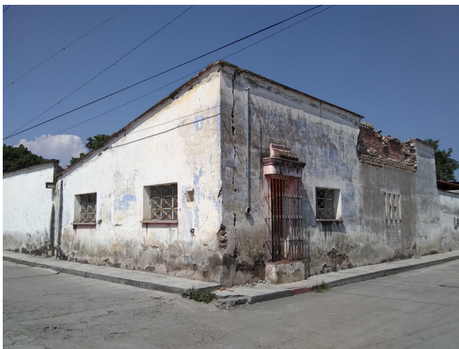
Figura 2.3.4 Vivienda sencilla de Jonacatepec, Morelos
