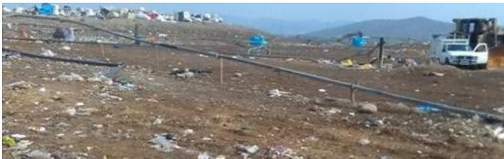
**Figura V-19 Tubos que captan el biogás**
