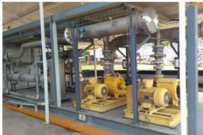
**Figura V-21 Maquinaria encargada de la generación de electricidad por medio del biogás**
