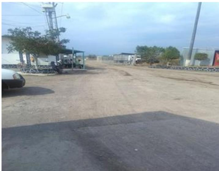
**Figura V-14 Falta de pavimentación de los caminos de accesos al relleno sanitario**
