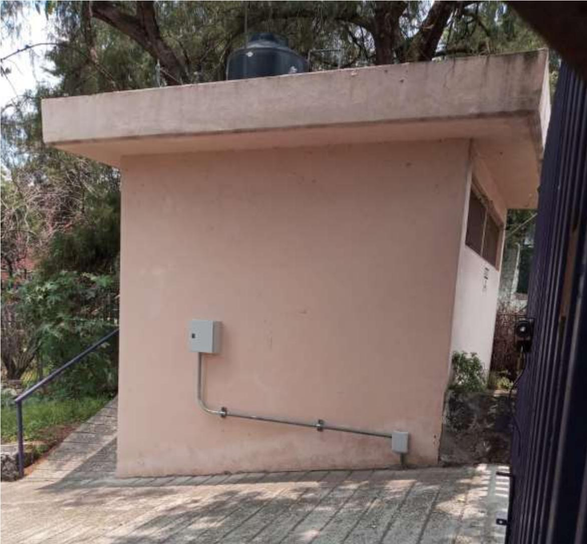
INSTALACIÓN ELÉCTRICA ANTIEXPLOSIVA DEL ALMACÉN TEMPORAL DE RESIDUOS PELIGROSOS DEL CIICA<sub>p</sub>
