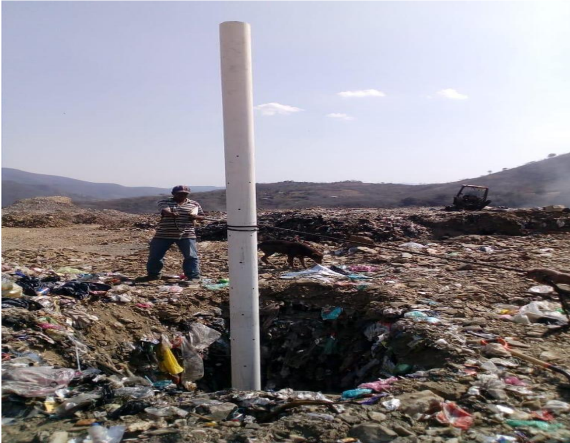
Ilustración 8: Colocación de tubos de venteo (Foto propia).
