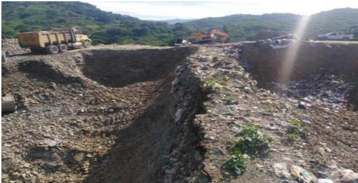
Ilustración 7: Construcción de celdas para la disposición de RSU (Protección Civil, 2022).
