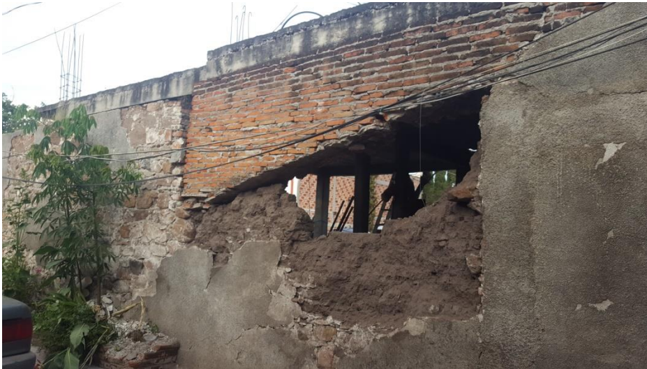
Foto 20 Construcciones mixtas, sin cadenas de cierre. Barda ubicada en calle Niño Artillero en Tepalcingo, Mor. Foto:Israel Zumaya
