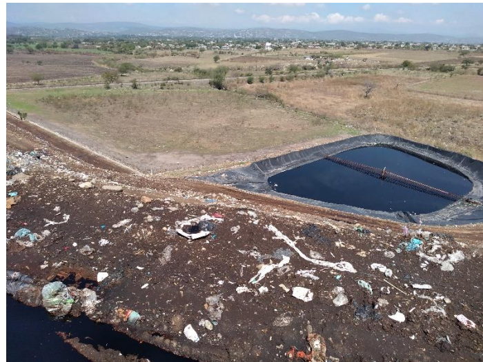
Figura 11. Relleno Sanitario "La Perseverancia". Manejo de lixiviados.
