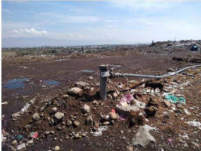
Figura 9. Relleno Sanitario "La Perseverancia". Sistema biogás
