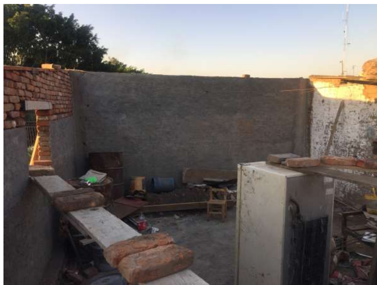
Fotografía 16. Interior de vivienda construida con ladrillos reutilizados
