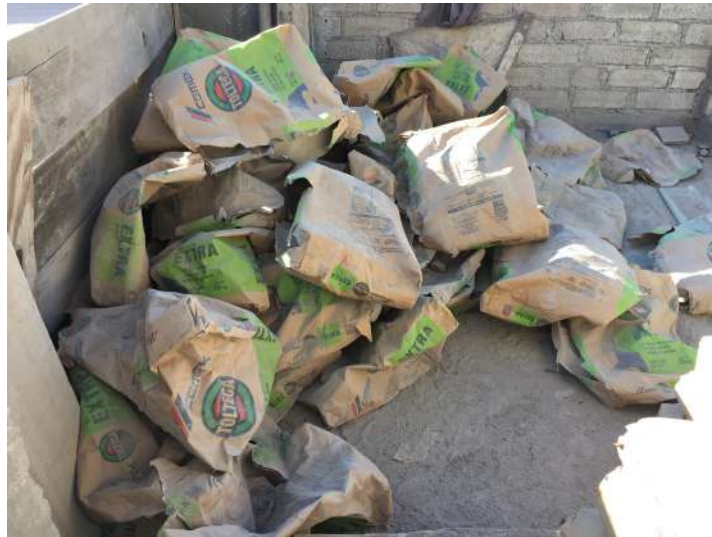
Fotografía 11. Almacenamiento de bolsas de cemento
