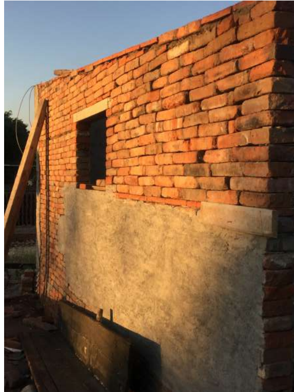
Fotografía 15. Exterior de muro reutilizando ladrillos
