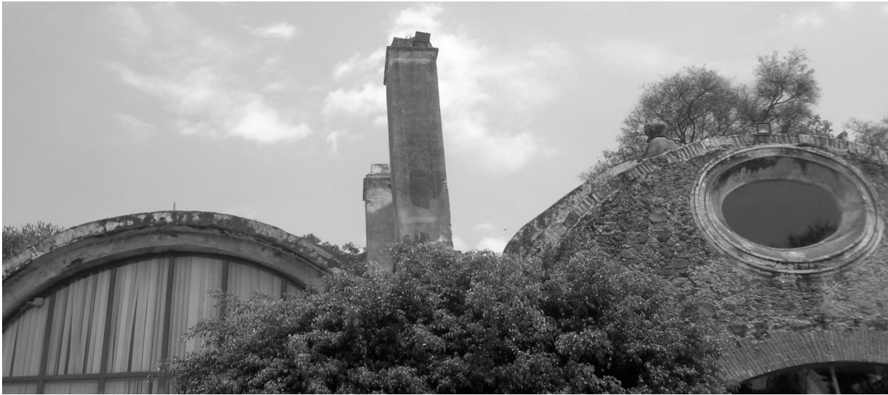
Figura 6. Foto de la antigua casa de calderas y sus chacuacos en la hacienda Cocoyoc. Foto y edición propia (2014).
