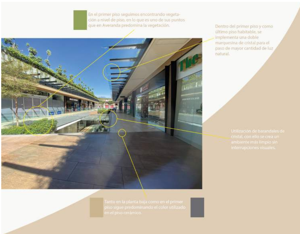
Figura 23: Nota: Dos tonalidades de colores implementados en el recubrimiento para el piso, como la utilización de cristal para marquesinas y barandales. por Ramírez, S., 2021
