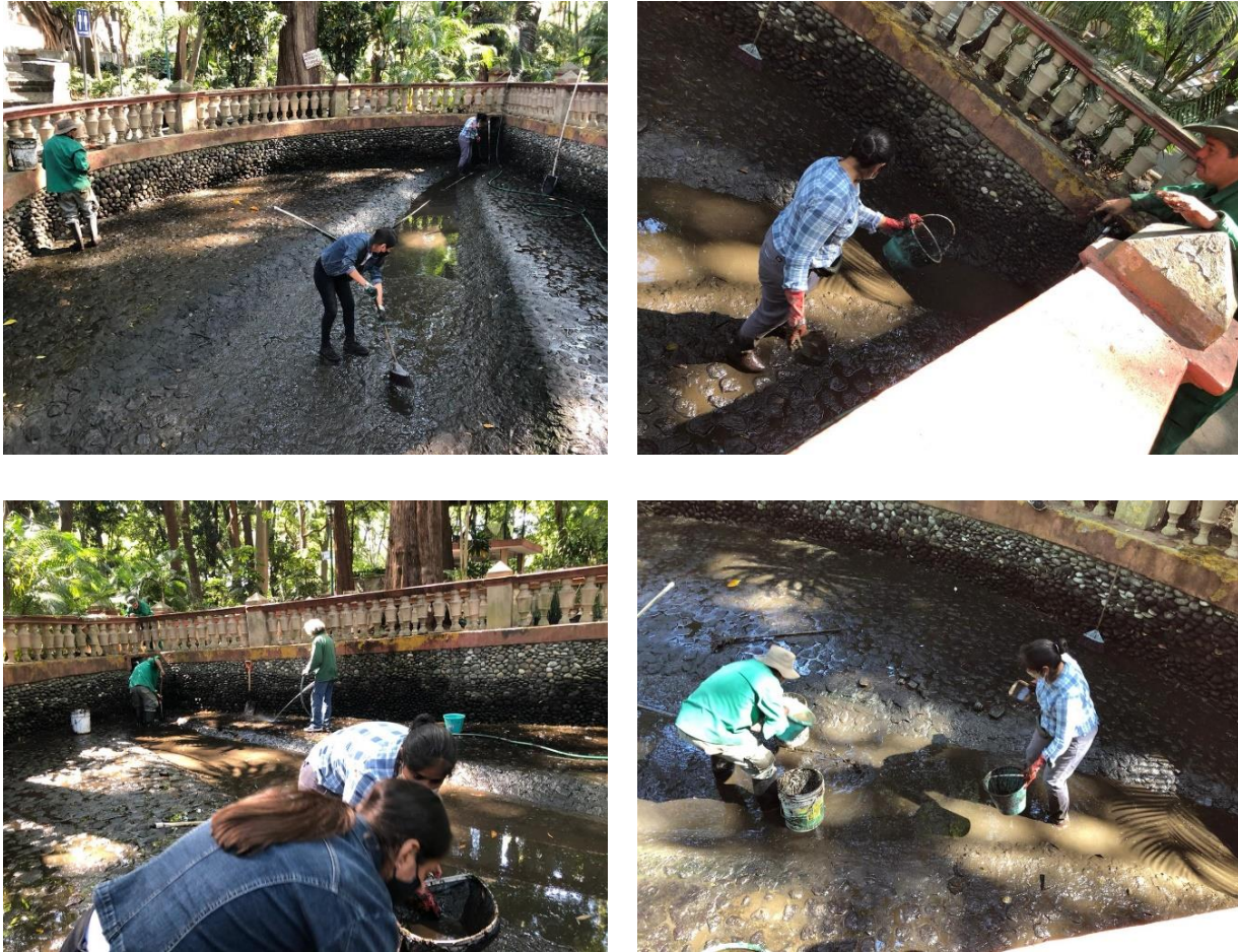
Figura 20. Proceso de limpieza de la poza grande en el manantial “La Gualupita” en el Parque Melchor Ocampo
