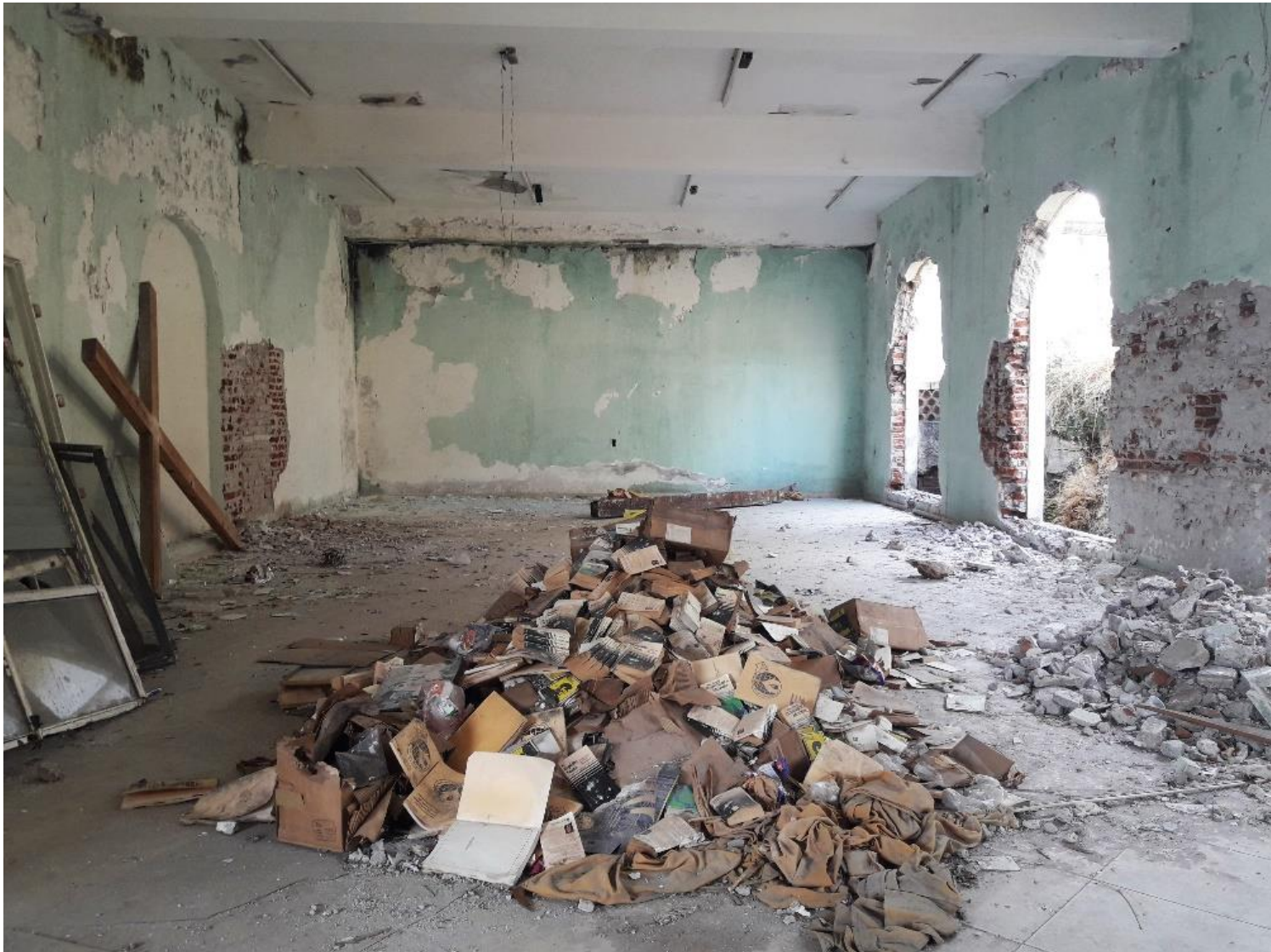
Foto: Interior del hotel en remodelación. 2018
