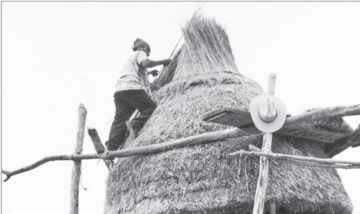
Figura 17. Colocación de la capa final del techo
