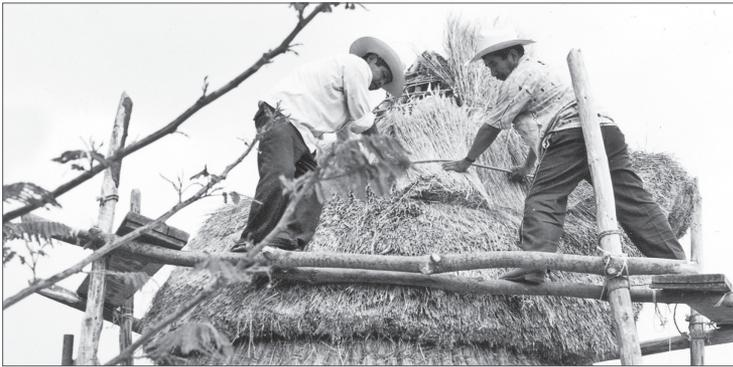
Figura 16. Forma de sujetar las capas de zacate
