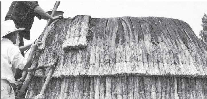
Figura 12. Colocación de las hileras superiores del “capote” o “naguas” de la olla
