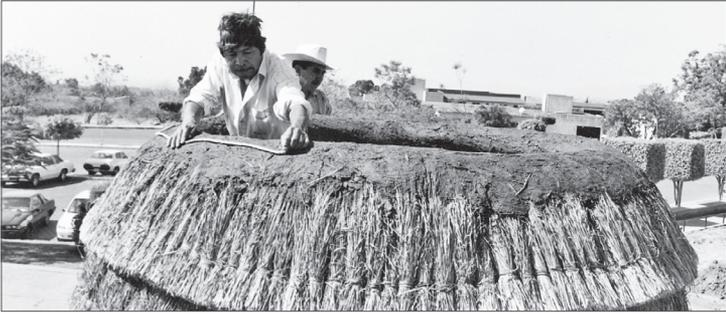
Figura 13. Determinación de perímetro del soporte circular del techo
