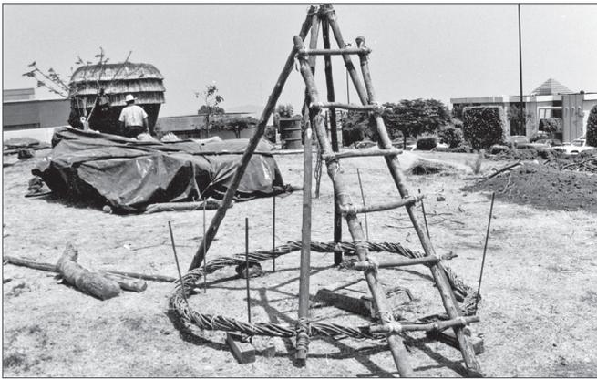
Figura 14. Forma conoidal inicial del techo
