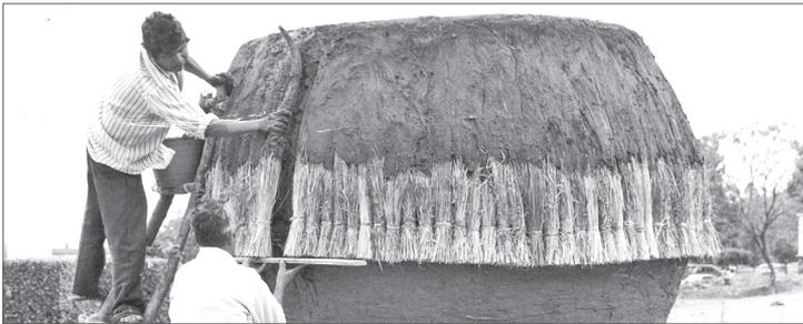
Figura 11. Colocación de la hilera inferior de rollos
