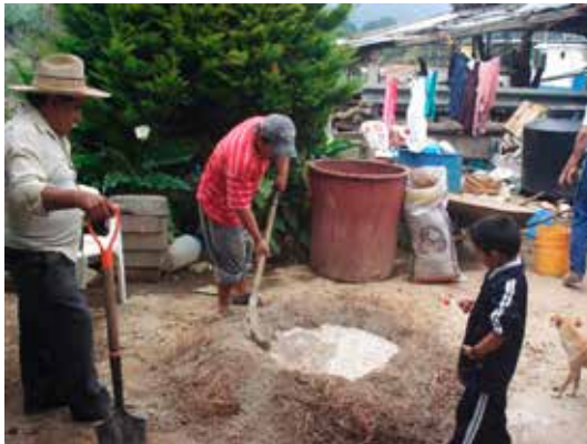
Figura 11. Inicio de la construcción de una estufa ahorradora de leña Tlecalli
