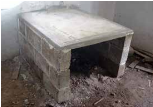
Figura 12. Pretil base para instalar la estufa ahorradora de leña Tlecalli
