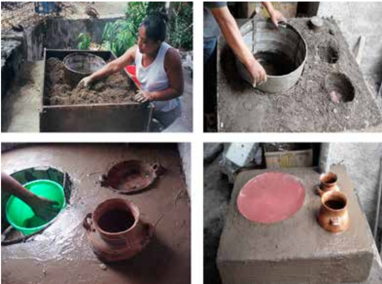
Figuras 13, 14, 15 y 16. Construcción de la estufa ahorradora de leña Tlecalli
