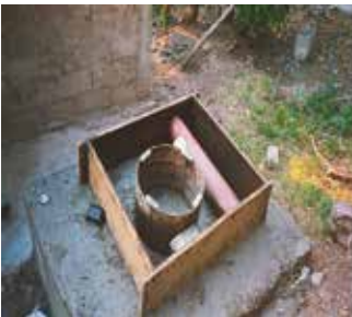
Figuras 9 y 10. Moldes para construir la estufa ahorradora de leña Tlecalli
